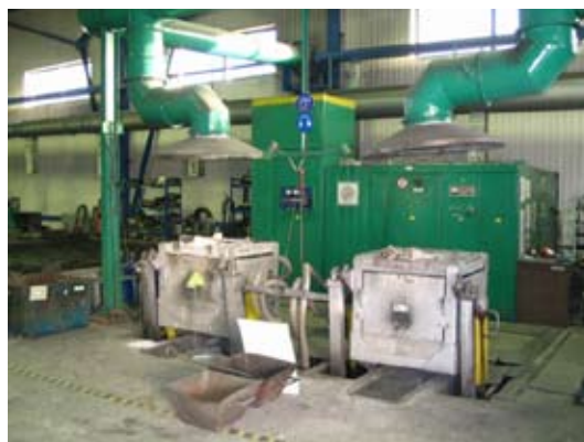
Рис. 4. Участок проведения опытно-промышленных испытаний
