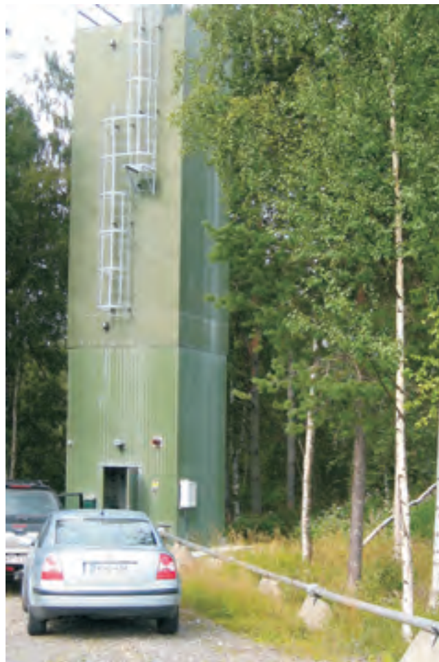
Kuva 3. Kalkkisiilo (kuva HyXo:n esittelymateriaali).
