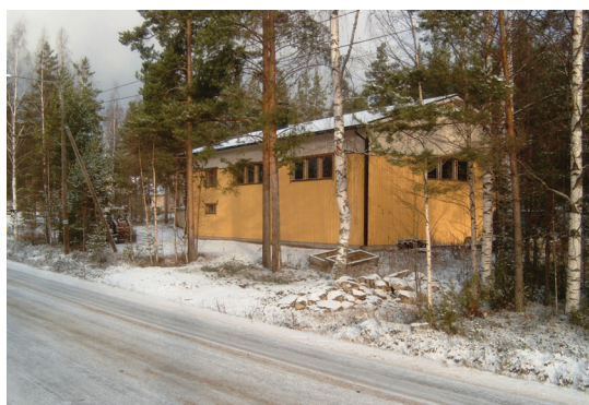
Kuva 45. Suurehko konehalli kylätien eteläpäässä on oikealla paikalla, väritys on sopivaa ja seinää on jaettu sekä rytmitetty ikkunoilla. Istutuksella tien puolella voitaisiin viimeistellä toimiva kokonaisuus.
