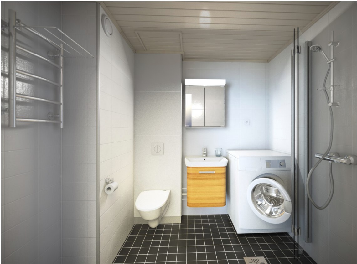
Kuva 1. R2i-kasetti asennettuna kylpyhuoneen kulmaan.
