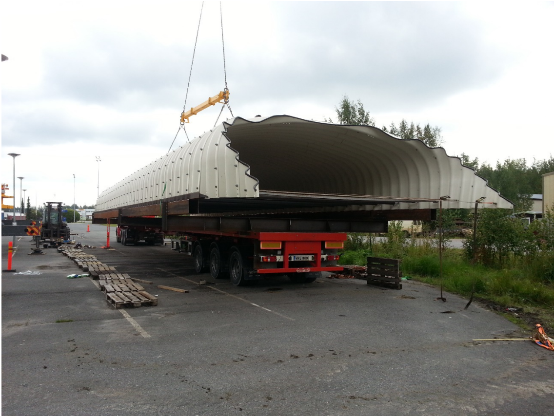
Kuva 18 Teräsholvikaari nostettuna kuljetusalustalleen Pirkkalassa.
