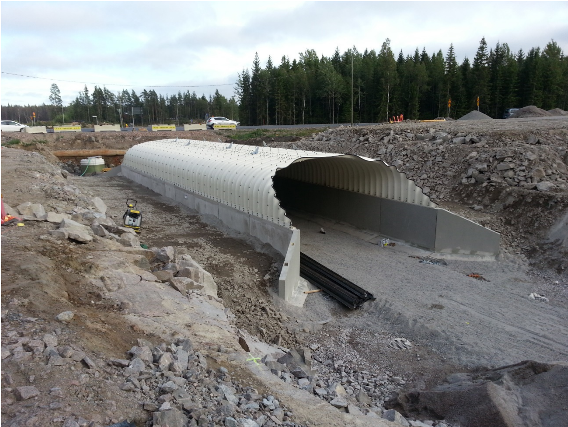
Kuva 21 Teräsholvikaari asennettuna paikalleen. Teräsholvikaaren päällä näkyvät nostokorvakkeet tullaan vielä irrottamaan sekä teräsholvikaaren ulkopuolella olevat paikkamaalaukset tekemään ennen suodatinkankaan asennusta ja lopullista maatyttöä.
