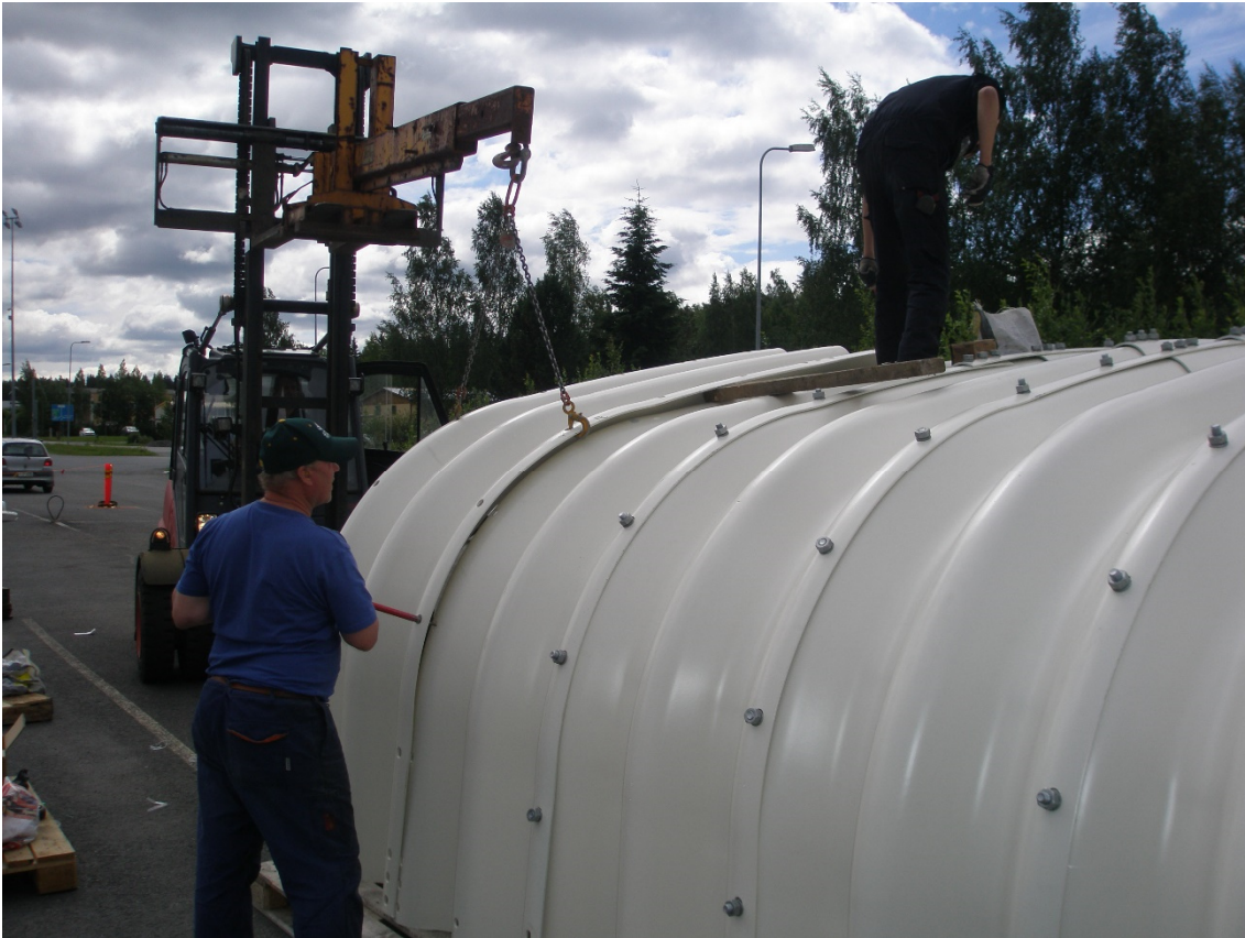
Kuva 15 Teräsholvikaaren kokoonpanoa Aurajoki Oy:n Pirkkalan tehtaalla. Yksi kaariosaa koostuu kolmesta monilevystä.
