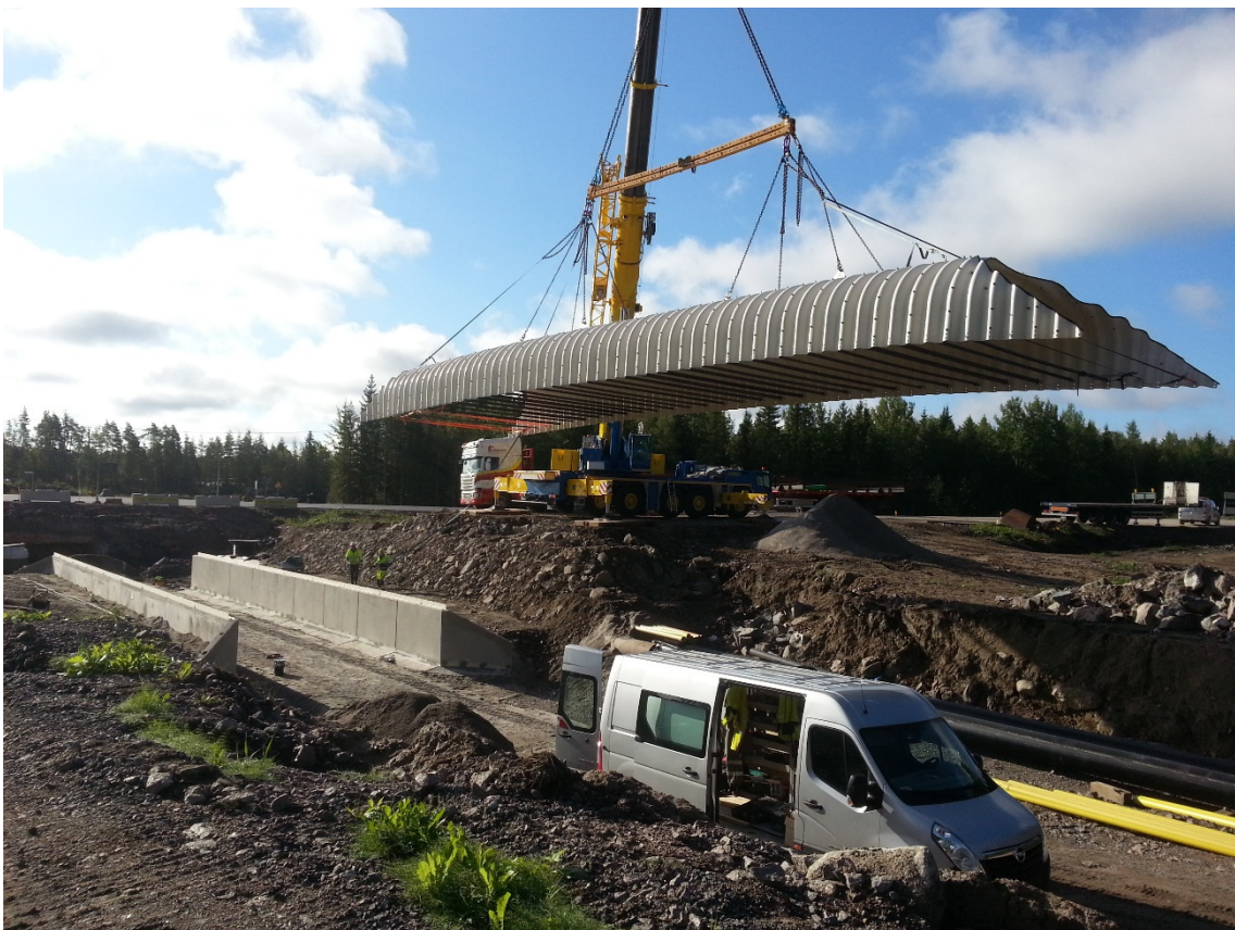
Kuva 19 Teräsholvikaaren nosto betonianturoille Raumalla valtatie 8:lla.
