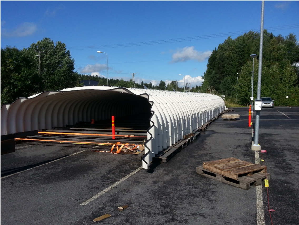
Kuva 16 Teräsholvikaari koottuna valmiiksi. Teräsholvikaaren mittoja ja muotoa kontrolloitiin kiristämällä sen sisäpuolelle vetotankoja ja kuormaliinoja.
