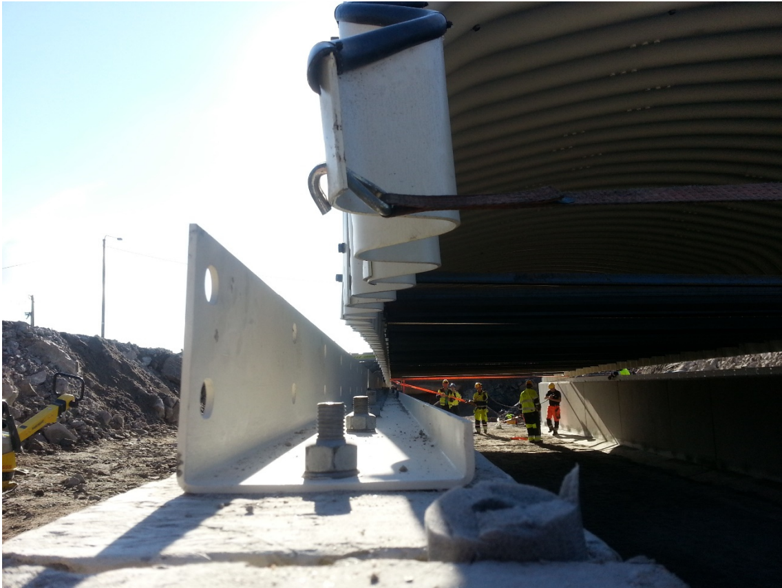
Kuva 20 Teräsholvikaaren tähtäämistä betonianturoihin kiinnitettyyn asennuskanavaan. Teräsholvikaari kiinnittyy asennuskanavaan kahdesta alimmasta pulttirivistään.
