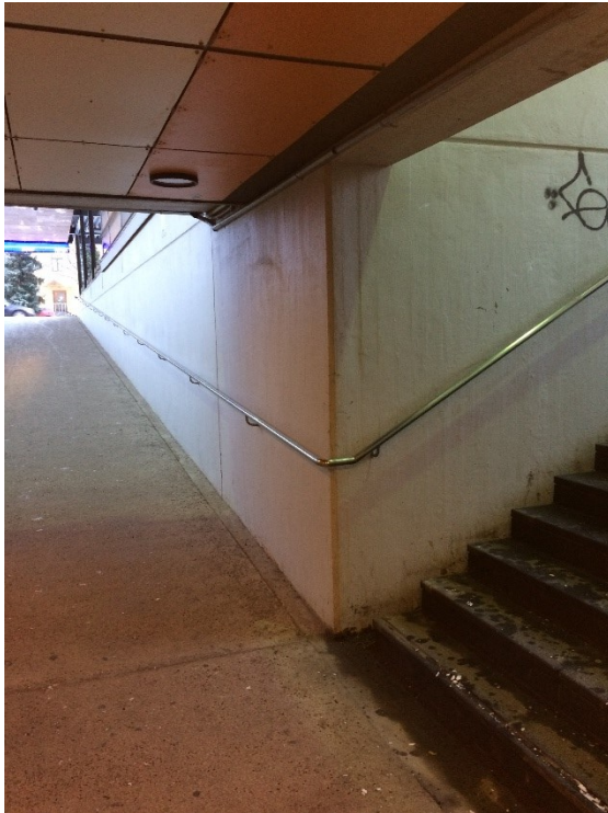
Kuva 6 Aseman alikulkuun johtavat portaat.
