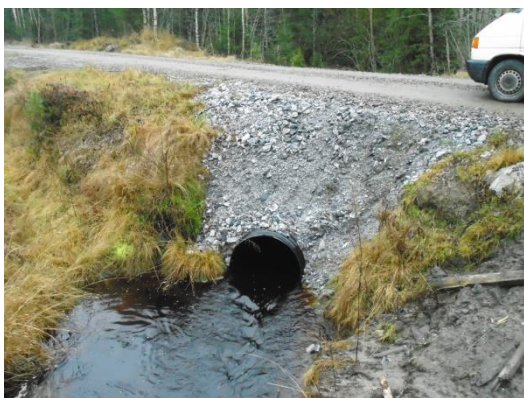
Figur 12. Gammalt trumrör utbytt.
