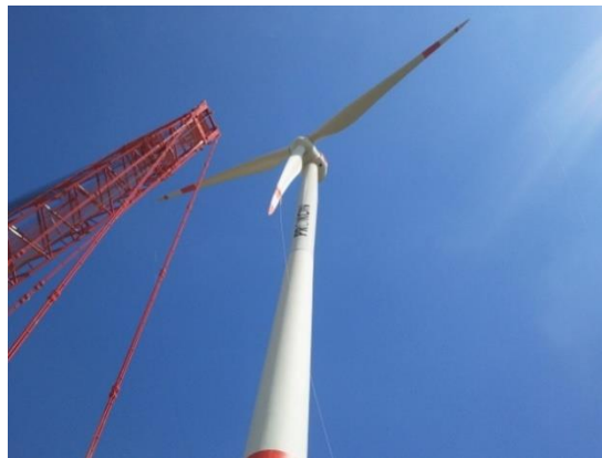
Figur 7. Färdigt monterade vingar.
