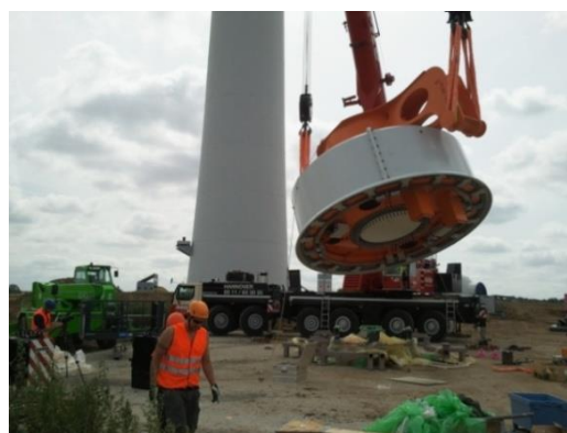
Figur 3. Generator (Prokons bild)
