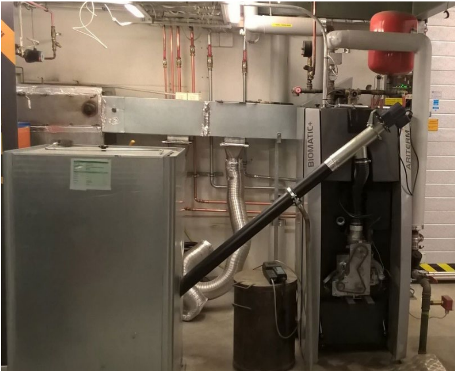
KUVA 3. Hevoslantapellettien polttokokeissa käytetty Kaakkois-Suomen ammattikorkeakoulun Ariterm Biomatic+ 20 pellettikattila (oikealla) ja pellettisiilo (vasemmalla) (kuva Riikka Tanskanen 2016).
