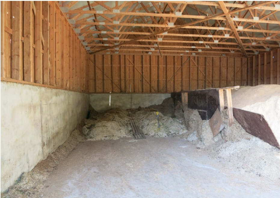
KUVA 5. Katettu lantala hevosenlannan välivarastoinnille. Lantala on erotettu väliseinällä kuivikevarastosta (kuva Jarno Föhr 2016).
