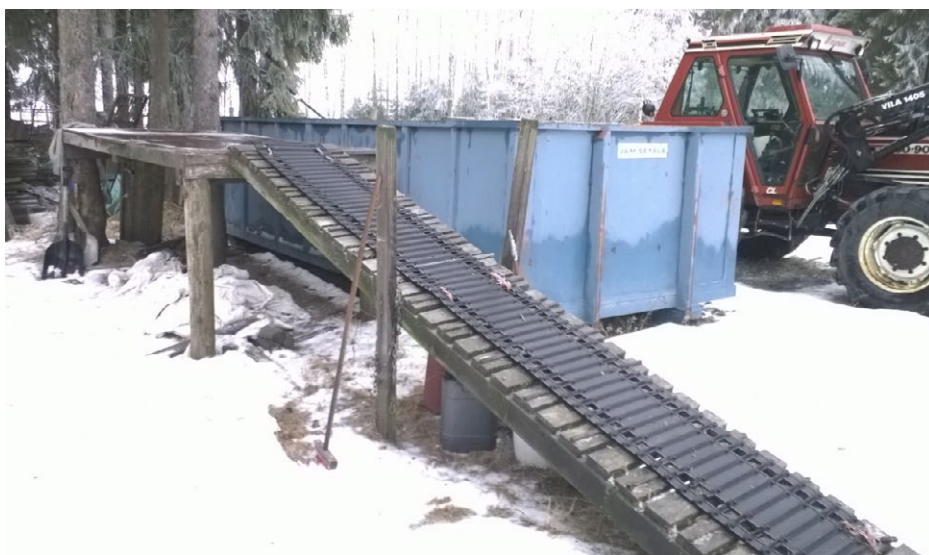
KUVA 2. Lastauslaituri helpottaa siirtolavan täyttämistä hevoslannalla, kun täyttö suoritetaan kottikärryillä (kuva Jarno Föhr 2017).
