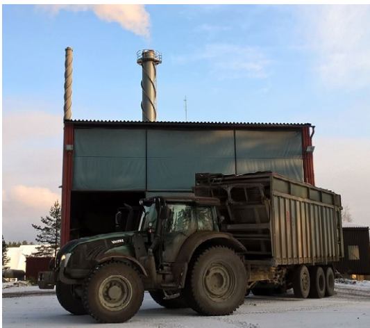
KUVA 1. Hevosenslannan koepoltto käynnissä Suur-Savon Sähkö Oy:n energiantuotantolaitoksella Juvalla (kuva Riikka Tanskanen 2016).
