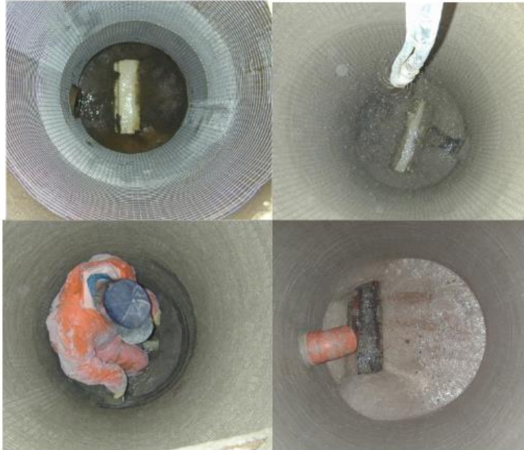
KUVA 21. Sementtilaastivuoraus teräsverkolla kaivossa /10/
