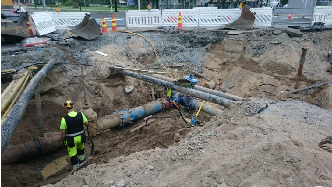
KUVA 18. Vanhan verkoston saneerausta uudelleen rakentamalla Kuopiossa
