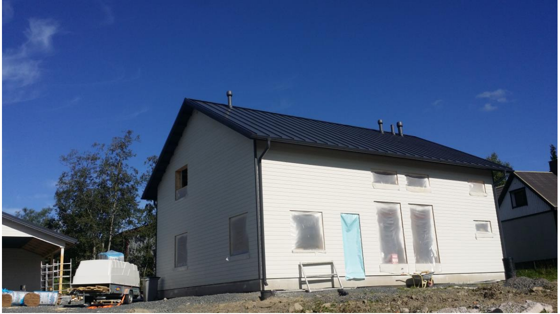
KUVA 30. Kohde rakenteilla. Kuva on otettu 24.9.2016 Lempäälässä.
