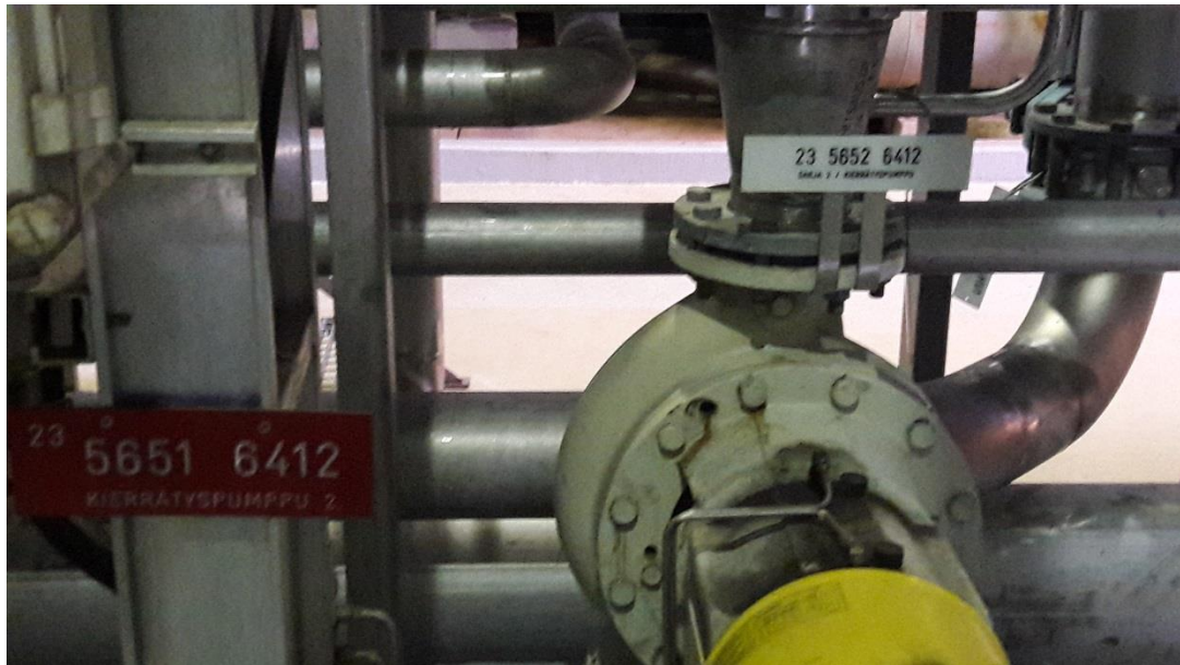
Kuva 9. Virheellinen tyyppimerkintä
