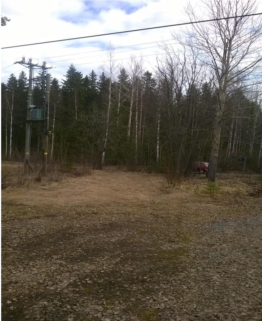
KUVA 21. Mahdollinen kytkentäpaikka erottimen E279 luona
