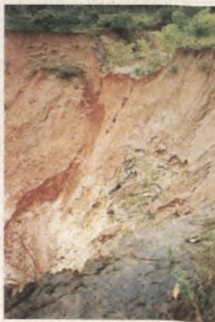
Fig. 5. Feição de escorregamento na vertente da escarpa do Chapadão.
