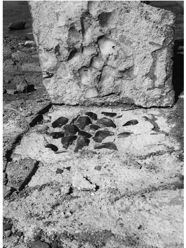
Fig. 1. Cama de cimentación de un mosaico de la Villa romana de "Las Tiendas". Foto archivo MNAR.
