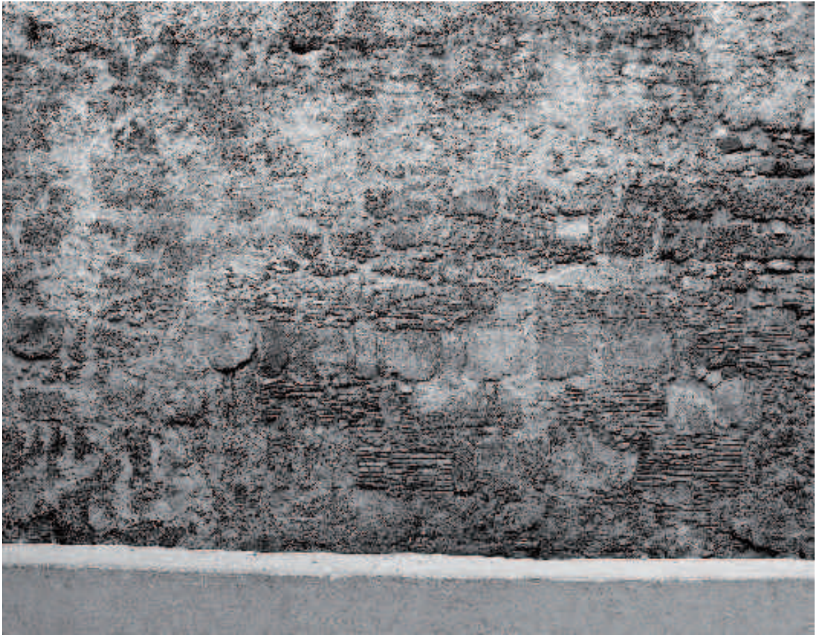
Figura 17. Detalle de elementos arquitectónicos en biocalcarenita reutilizados en el paramento medieval del Castillo de Cádiz, en el tramo recientemente restaurado, paralelo a la calle San Juan de Dios
