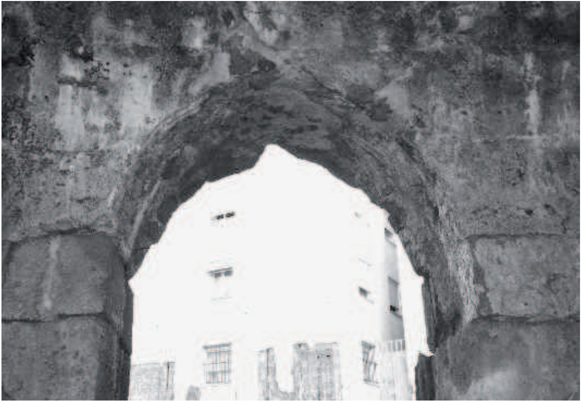
Figura 13. Bóveda del segundo vomitorio, con el retalle del caementicium tras la reforma arquitectónica
