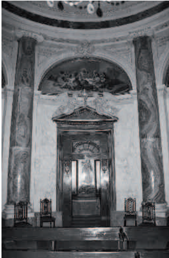
Figura 18. Capilla Alta del Oratorio de la Santa Cueva, con la localización de las columnas
