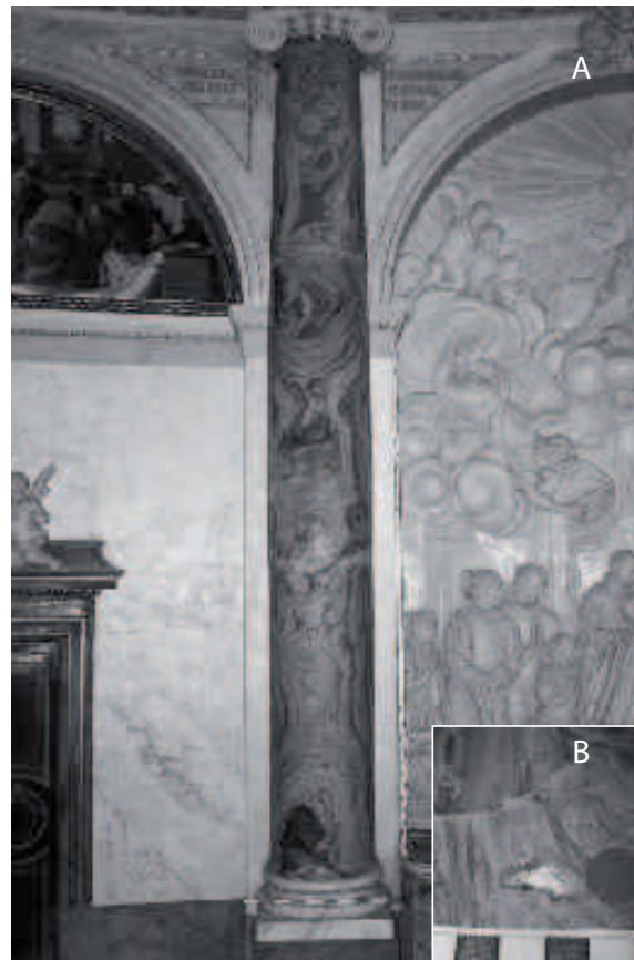
Figura 19. Fotografía de una de las columnas (A), y detalle de la vacuola en una de ellas (B)
