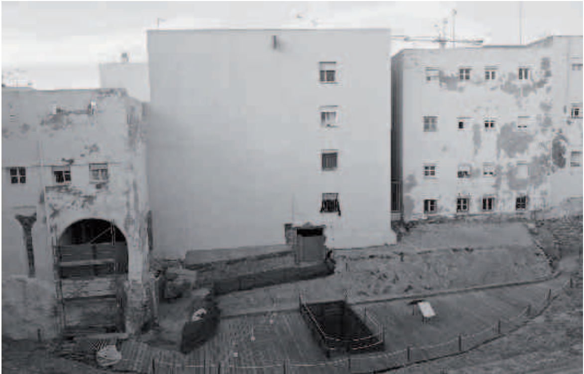
Figura 23. Vista aérea de la zona a excavar en la ima cavea
