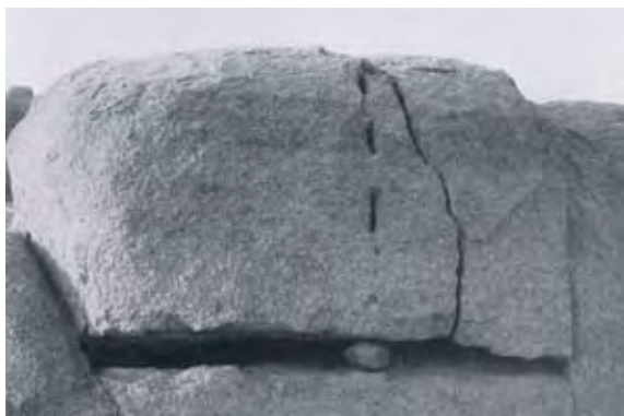
Fig. 3. Improntas de mortajas para la inserción de cuñas y lesión en el granito (De La Barrera 2000).
