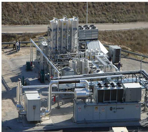
Figura 1.8 Planta de purificación de biogás mediante separación criogénica (EEUU) [33].
