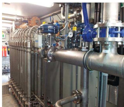
Figura 1.7 Planta de purificación de biogás mediante la tecnología de separación con membranas. Poundbury (Reino Unido). Capacidad: 650 \text{ Nm}^3 \text{ hora}^{-1} Imagen de DMT [27].
