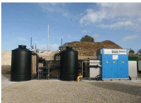
Figura 1.7 Planta de purificación de biogás mediante la tecnología de separación con membranas. Poundbury (Reino Unido). Capacidad: 650 \text{ Nm}^3 \text{ hora}^{-1} Imagen de DMT [27].
