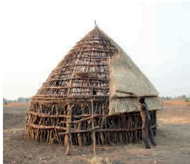
Figura 47. Un hombre nuer techa un establo de vacas en Pakang. Se puede observar la fuerte construcción de las paredes, a base de troncos, muy distinta del endoble entrelazado de bambú o ramas de los dormitorios y cocinas (comparar con figura 45). Nótese también la calidad del techo, sorprendente para una cuadra. El esfuerzo invertido en esta es comprensible si se tiene en cuenta en legendario valor del ganado entre los nuer.
