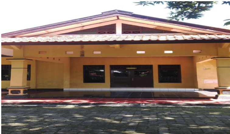
Kantor Unit Rehabilitasi Sosial Bina Sejahtera Kendal I
