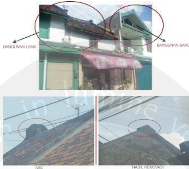
Gambar 6. Bangunan Lama dan Baru serta Sebelum-Sesudah Renovasi
