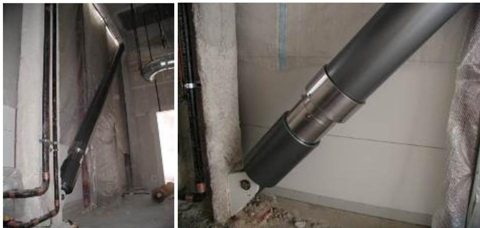
Figura 1.5: amortiguadores antisísmicos con 1670 kN de fuerza máxima, instalados durante la construcción del centro de investigación y tecnología Helix Project de Immunex Corp, con 3 pisos en Seattle, WA, EEUU, 2002. Izquierda: instalación de un amortiguador. Derecha: detalle de la conexión amortiguador-estructura. Fotografías cedidas por la empresa Taylor Devices Inc.
