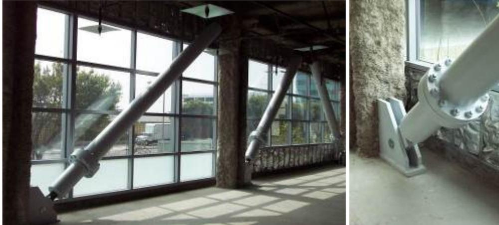
Figura 1.4: amortiguadores antisísmicos con 2670 kN de fuerza máxima, usados en la actualización (*retrofitting*) de un edificio de 8 pisos construido en 1962 en Los Angeles, CA, EEUU. Izquierda: instalación de los amortiguadores. Derecha: detalle de la conexión amortiguador-estructura. Fotografías cedidas por la empresa Taylor Devices Inc.
