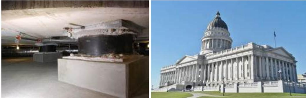
Figura 1.2: izquierda: sistema aislador antisísmico entre la fundación y la superestructura del Utah State Capitol Building [4] y derecha: vista exterior del edificio en 2010 [5].
