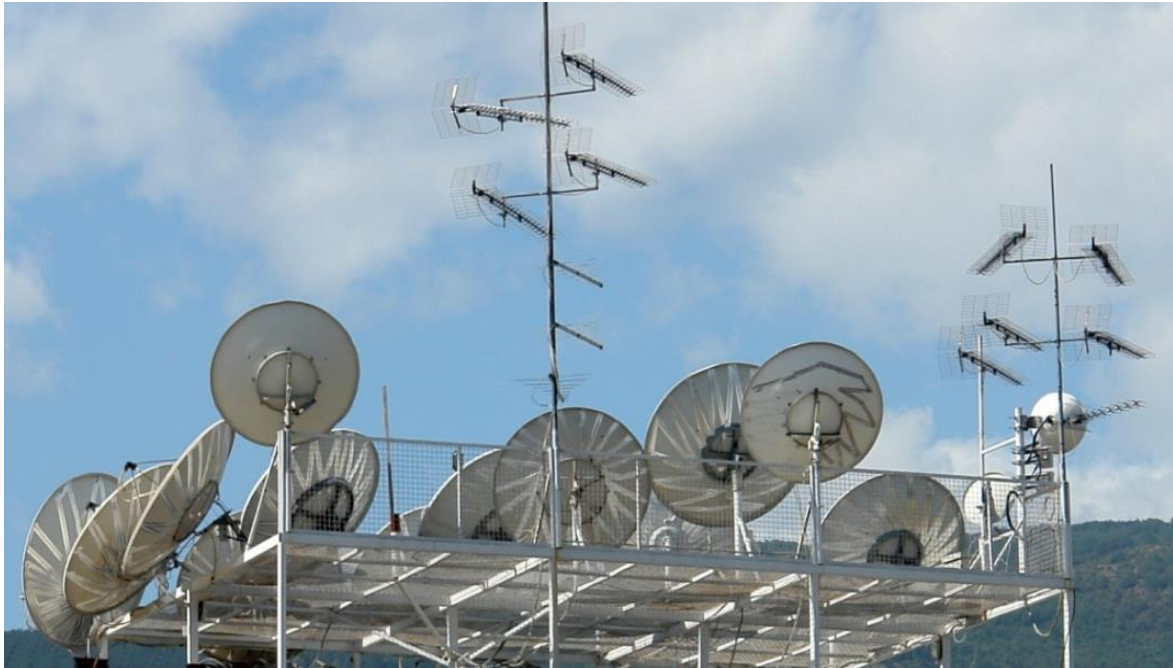
Слика 2. Антенски приемен систем на современ КДС
