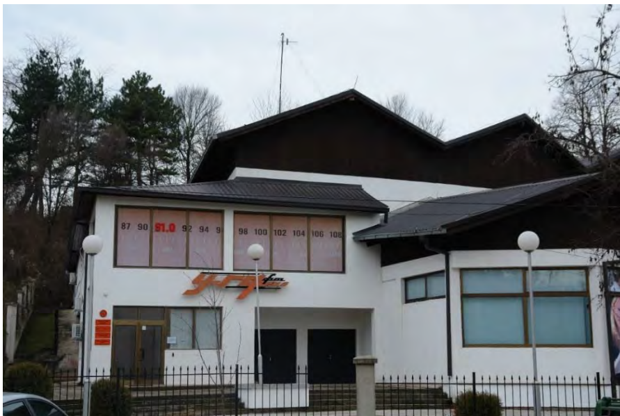
Слика 35. Локален извор на електромагнетно зрачење означен со број 15 Figure 35. Local source of electromagnetic radiation marked with number 15
