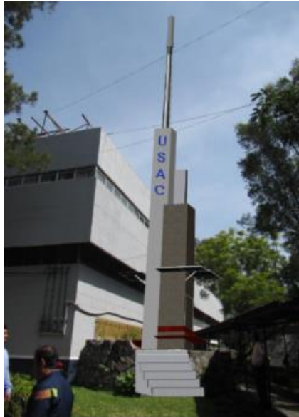
Figura 88. Punto geográfico propuesto para la instalación de los equipos a un costado del edificio T1
