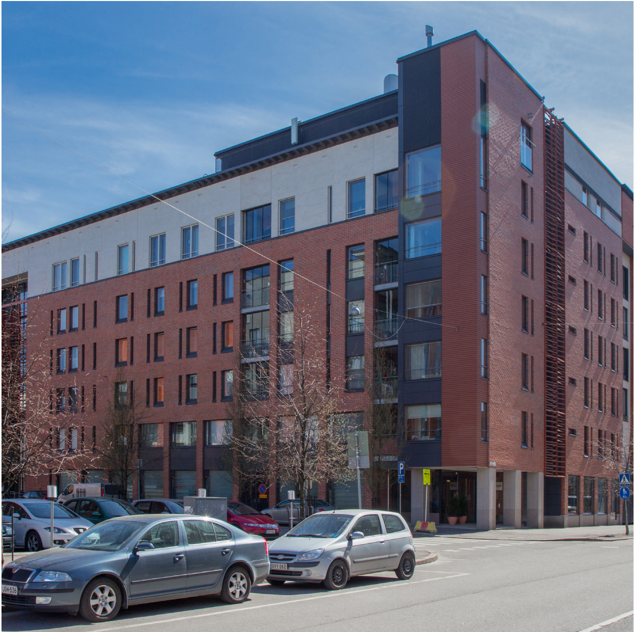
Loppukirin katujulkisivu on muiden Arabianrantaan talojen tavoin punatiiltä.
