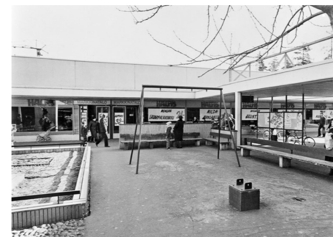
KUVA 15. Eri toimintoja rajattiin toisistaan kalustein ja muurirakentein. Kuvassa Kontulan ostoskeskuksen leikkipaikka vuonna 1970.
