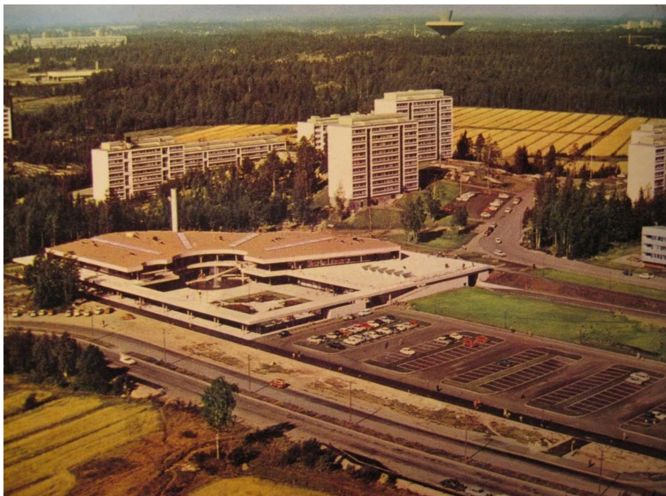
KUVA 7. Puotinharjun puhos sijaitsi aivan Turunlinnantien varrella, mutta siltä ei ollut suoraa kulkuyhteyttä ostoskeskukseen. Sittemmin liikennejärjestelyt ovat muuttuneet huomattavasti muun muassa Itäkeskuksen rakentamisen myötä.
