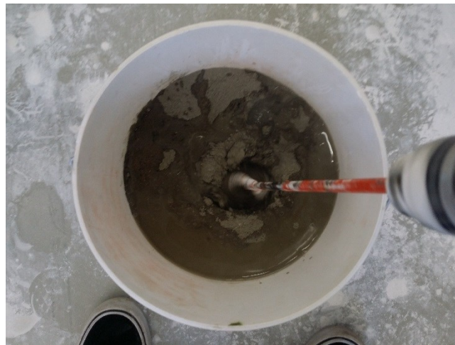
Kuva 7 Betonin sekoitus porakoneen ja vispilän avulla
