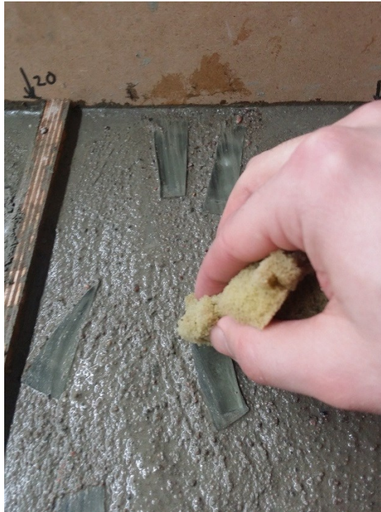
Kuva 13 Betonivalun pinnan peseminen ennen valun lopullista kovettumista, kun valu on hetken jämähtänyt
