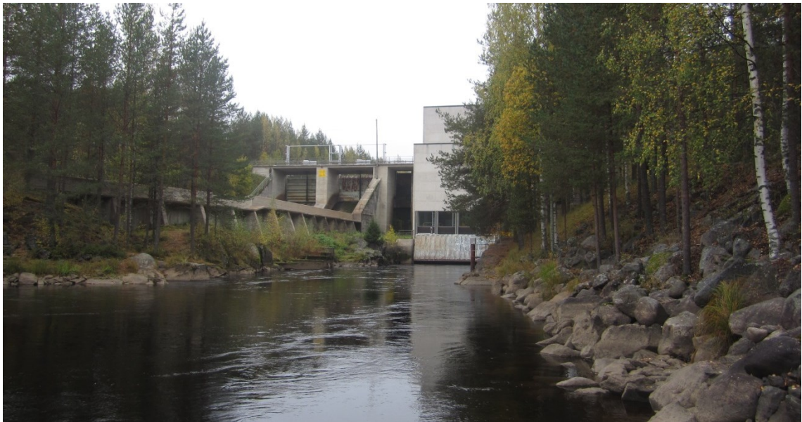
Figur 23. Nedströms vattenkraftverket i Hietamankoski. (Foto: Axel Andersson.)
