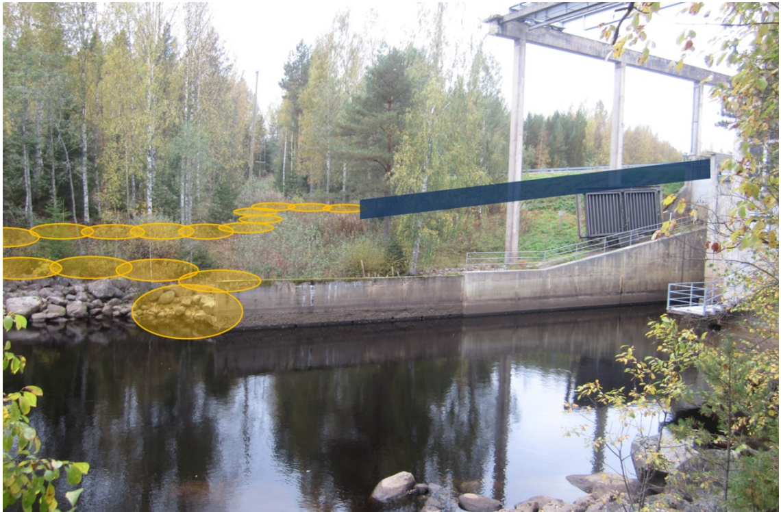
Figur 27. Ungefärlig placering av den planerade fiskvägen i Leuhunkoski, där de gula cirklarna föreställer den fiskvägens naturlika bassänger och den lila rampen föreställer fiskvägens tekniska avsnitt. (Foto och grafik: Axel Andersson.)
