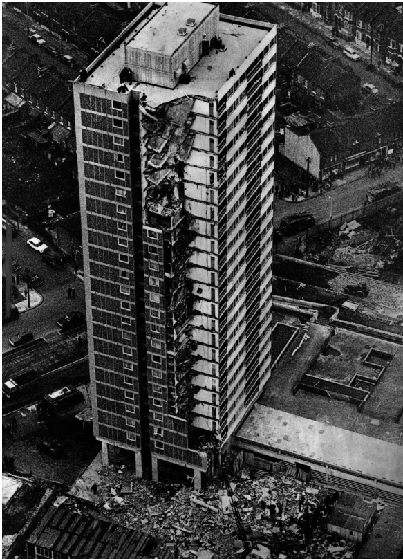
Kuva 1-1, Ronan Point-asuinkerrostalon sortuma (Lähde: http://mixstuff.ru/wp-content/uploads/2013/06/119.jpg )
