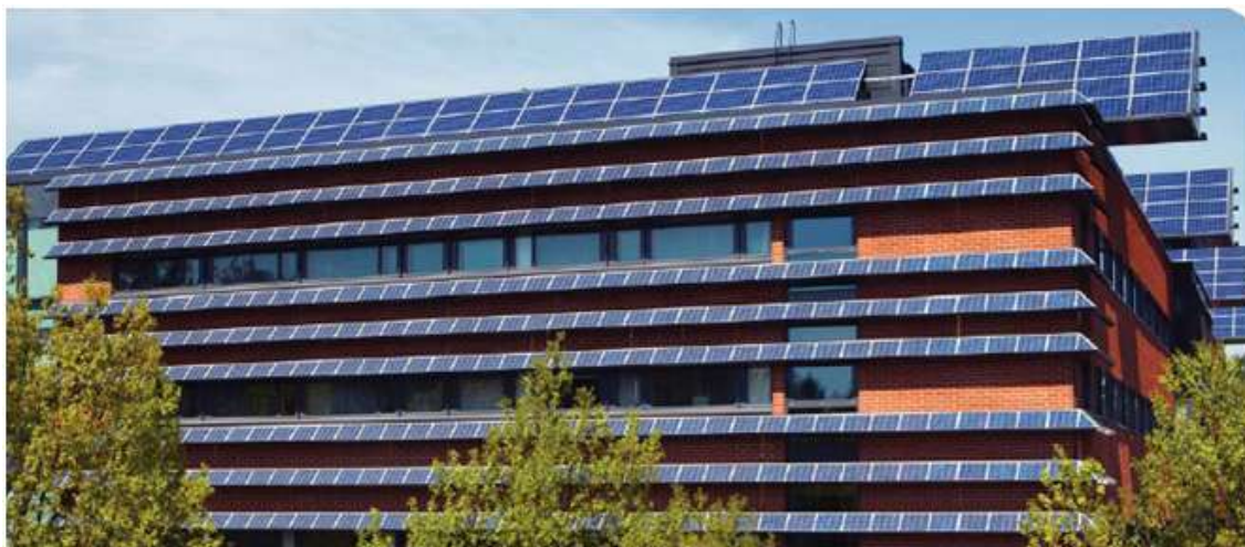
Kuva 11. Aurinkosähköpaneeli aurinkosuojalippana Vaisalán päärakennuksessa (Naps Systems Oy 2013b, verkkokuva)
