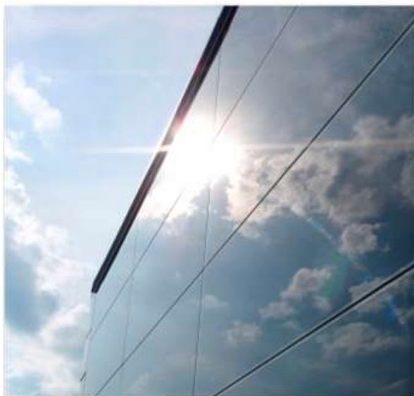
Kuva 9. Aurinkosähköpaneeli seinän julkisivussa (Rautaruukki Oyj, Ruukki kuvapankki)
