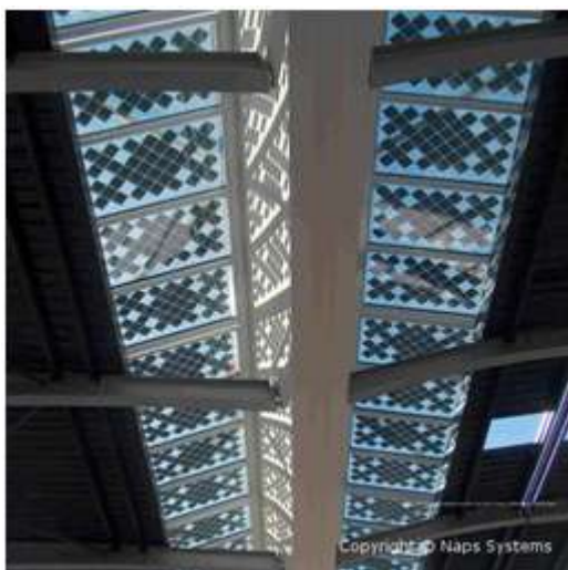
Kuva 10. Aurinkosähköpaneelit kattolaseihin integroituna Marrakech lentokentällä Marokossa (Naps Systems Oy 2013a, verkkokuva)
