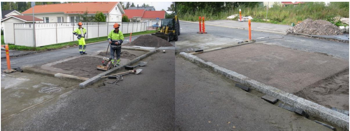
Vasen: asennushiekan tiivistystä. Oikea: tiivistetty ja tasattu asennushiekkakerros.
