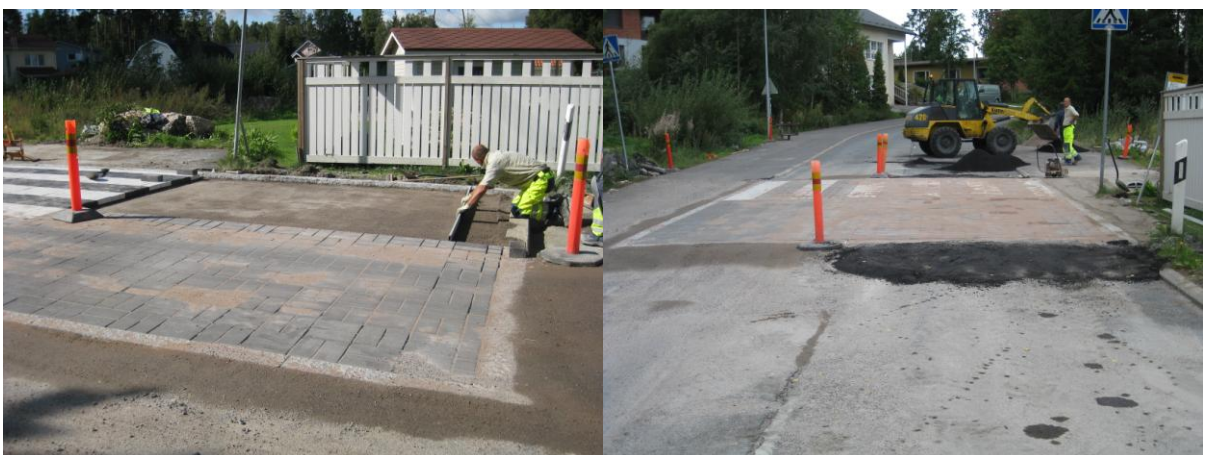
Vasen: toisena työpäivänä asennustyö etenee vastaavasti kuin ensimmäisenä. Oikea: päällyste viisteitä lukuunottamatta valmis. Saumaushiekkaa jätetään päällysteen päälle, sillä saumaushiekan tiivistyessä päällä oleva hiekka valuu saumoihin.
