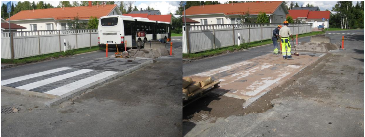
Vasen: puolikkaan korotuksen kivet ladottuna. Oikea: saumaushiekan levitystä.
