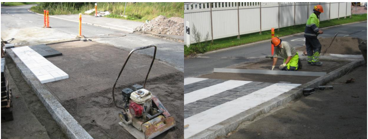
Vasen: kivien ladontaa. Oikea: asennushiekkakarros tasataan oikolaudalla.
