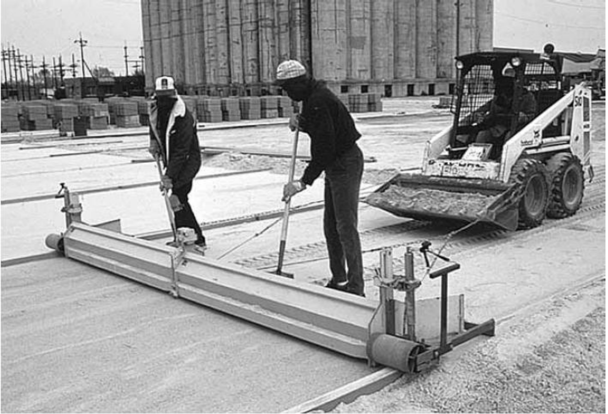
Kuva 3 Reunakiven päällä vedettävä oikolauta (ICPI 2004b).
