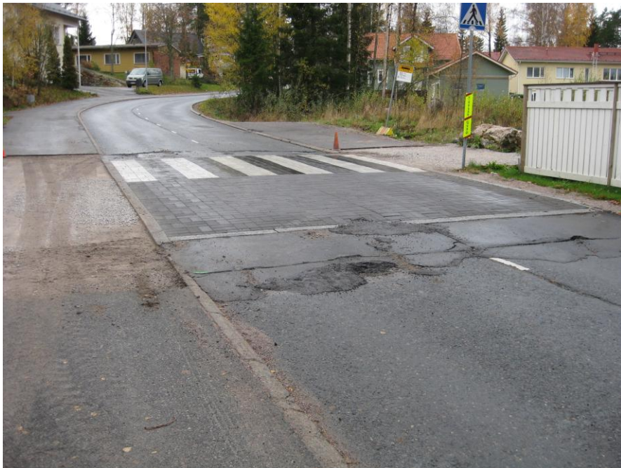
Kuva 38 Saneerattu korotettu suojatie. Kuva otettu 21.10.2011.
