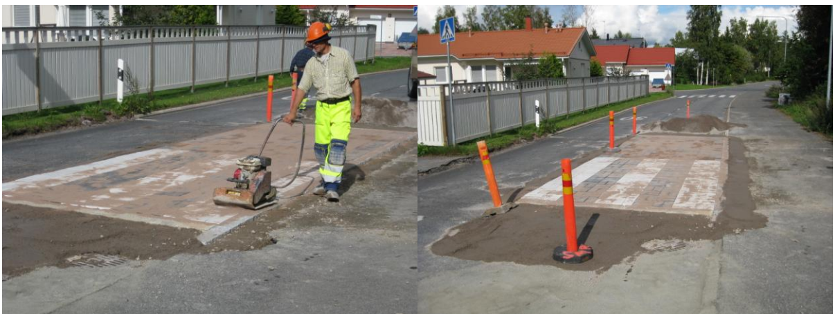
Vasen: lopuksi päällyste täyrytetään. Oikea: kohde ensimmäisen työpäivän jälkeen.
