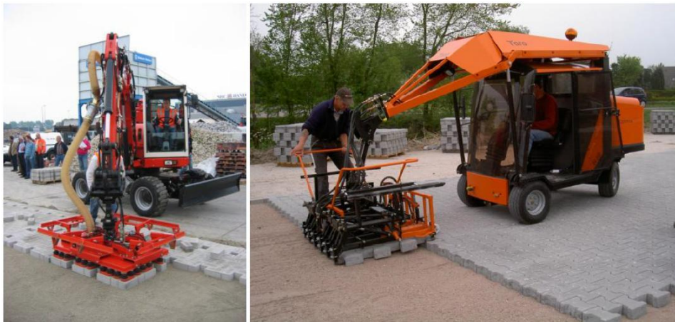
Kuva 14 Koneellista asennusta, vasemmalla alipainetarrain (Houben ja Knol 2009).
