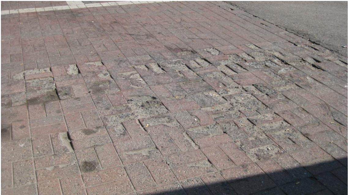
Kuva 33 Myyrmäen terminaalien taksiaseman pääty.
