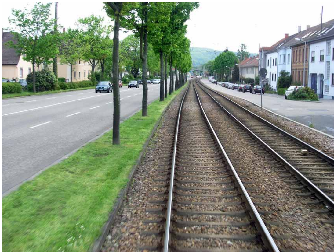
Kuva 16. Kaksi tapaa erottaa raitiovaunu- ja autokaista. Vasemmalla viherkaista jossa myös puurivi ja oikealla reunuskivi. Lisäksi rata on sepelipohjainen avorata, jolle autoilijat eivät luonnostaan halua ajaa. Karlsruhe, Saksa 2005.
