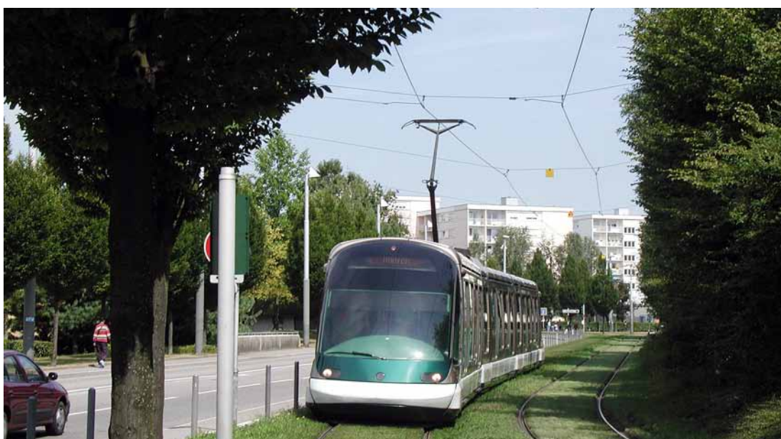
Kuva 10. Raitiotien ja autoliikenteen erotus sijoittamalla raitiotierata kadun reunaan. Kuva Ranskan Strassbourgin esikaupunkialueelta vuodelta 2003.
