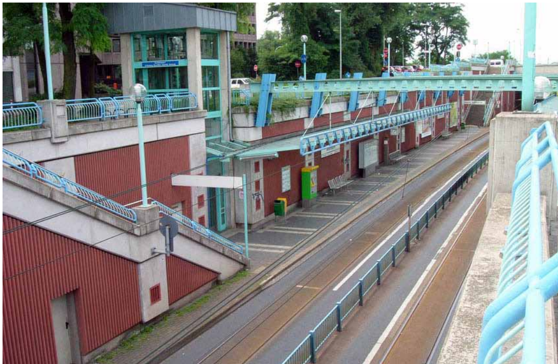
Kuva 45. Eri tasoon sijoitettu pysäkki Arbeitsamt Oberhausenissa Saksassa. Joukkoliikennekatu, jolla kulkee sekä raitiovaunuja että busseja, on sijoitettu taajamakeskuksessa eritasoon avoimeen kaukaloon. Esteetön kulku pysäkillä on järjestetty hissillä. Avoimessa rakenteessa ei ole kattamattomia rullaportaita. Heinäkuu 2003.
