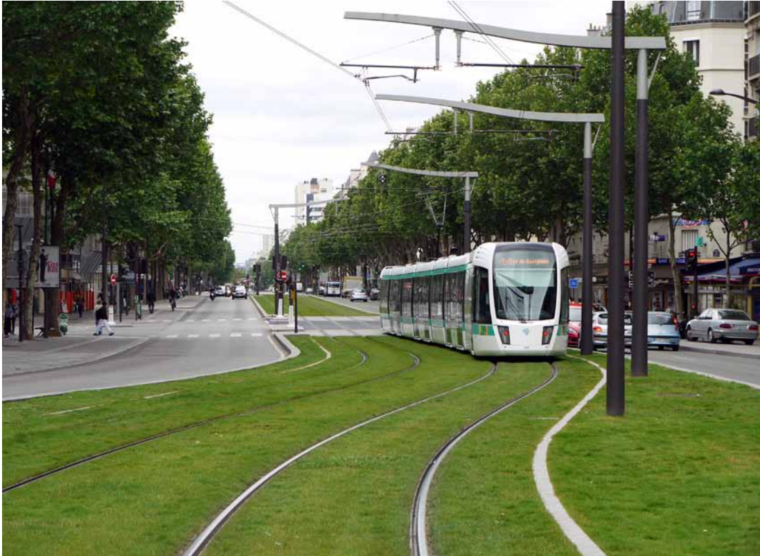
Kuva 14. 4-kaistaisen kadun keskelle sijoitettu nurmetettu rata Pariisin linjalla T3. Ajouradan reunalla on reunuskivi ja radan kuormauttuman ja reunuskiven välissä on noin metrin levyinen tila, johon mahtuvat ajojohtopylväät, liikennemerkit ja valo-opasteet. Reunakivi ja nurmetus ovat luotettava este autojen ajolle rata-alueelle. Kuva kesäkuulta 2010.
