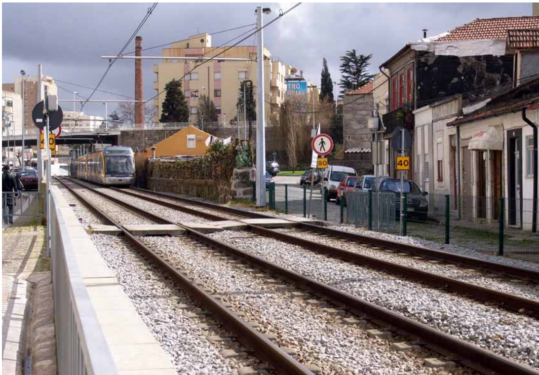
Kuva 63. Kävelytie aidatun radan poikki Portugalin Portossa. Radan nopeus on 80 kilometriä tunnissa, minkä vuoksi rata on aidattu. Kävelytien kohdalla on pistemäinen 40 kilometriä tunnissa nopeusrajoitus. Tavallinen menettely nykyaikaisilla raitioteillä on nopeusrajoitusten pakko-ohjaus, jolloin pistemäisen nopeusrajoituksen noudattaminen ei riipu kuljettajan huolellisuudesta. Maaliskuu 2007.
