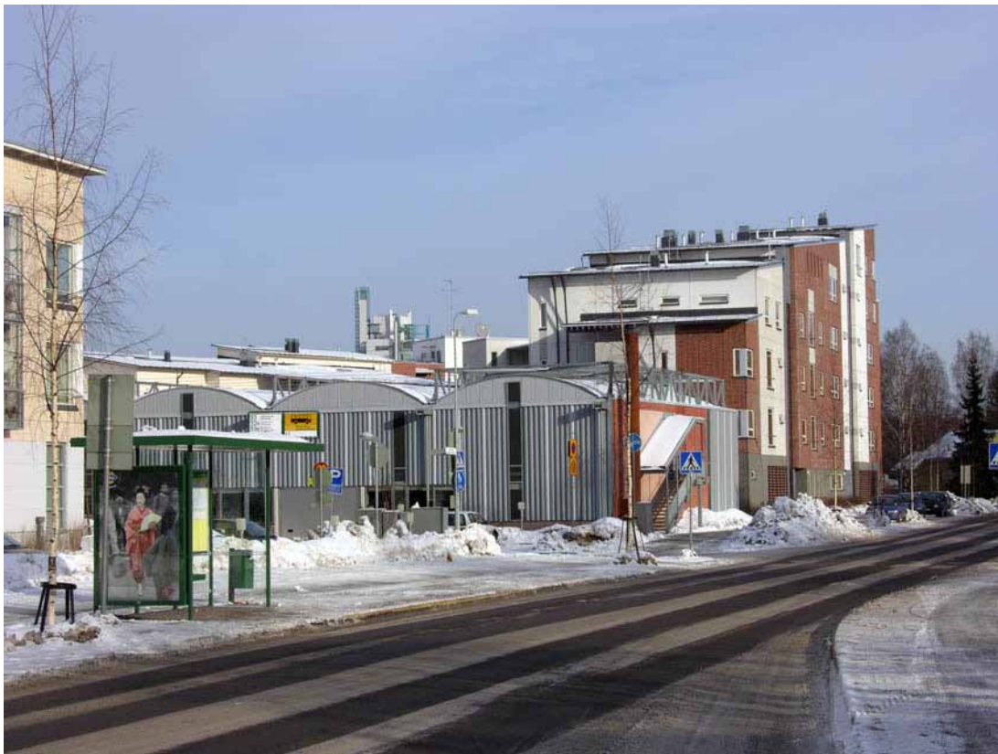
Kuva 47. Kaarikattoinen pysäköintirakennus Helsingin Itäkeskuksessa. Pysäköintirakennus vie tontin pinta-alaa saman verran kuin sen takan näkyvä asuinkerrostalo. Helmikuu 2004.
