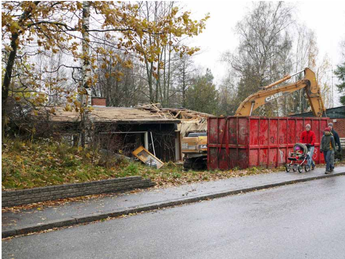
Kuva 52. 1960-luvulla valmistunutta omakotitaloa puretaan Itä-Helsingissä marraskuussa 2010. Tontille nousevassa uudisrakennuksessa on noin kaksinkertainen pinta-ala purettuun verrattuna.
