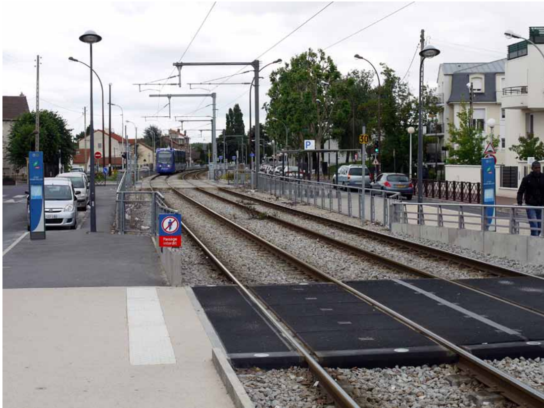
Kuva 65. Tasoristeys sekä pysäkin yhteydessä oleva kävelytie radan yli. Rata on eristetty aidalla. Kulku radalle ylityspaikoista estyy luontevasti radan päällysrakenteen vuoksi, sillä se peli ei houkuttele kävelijöitä. Pariisi kesäkuu 2010.
