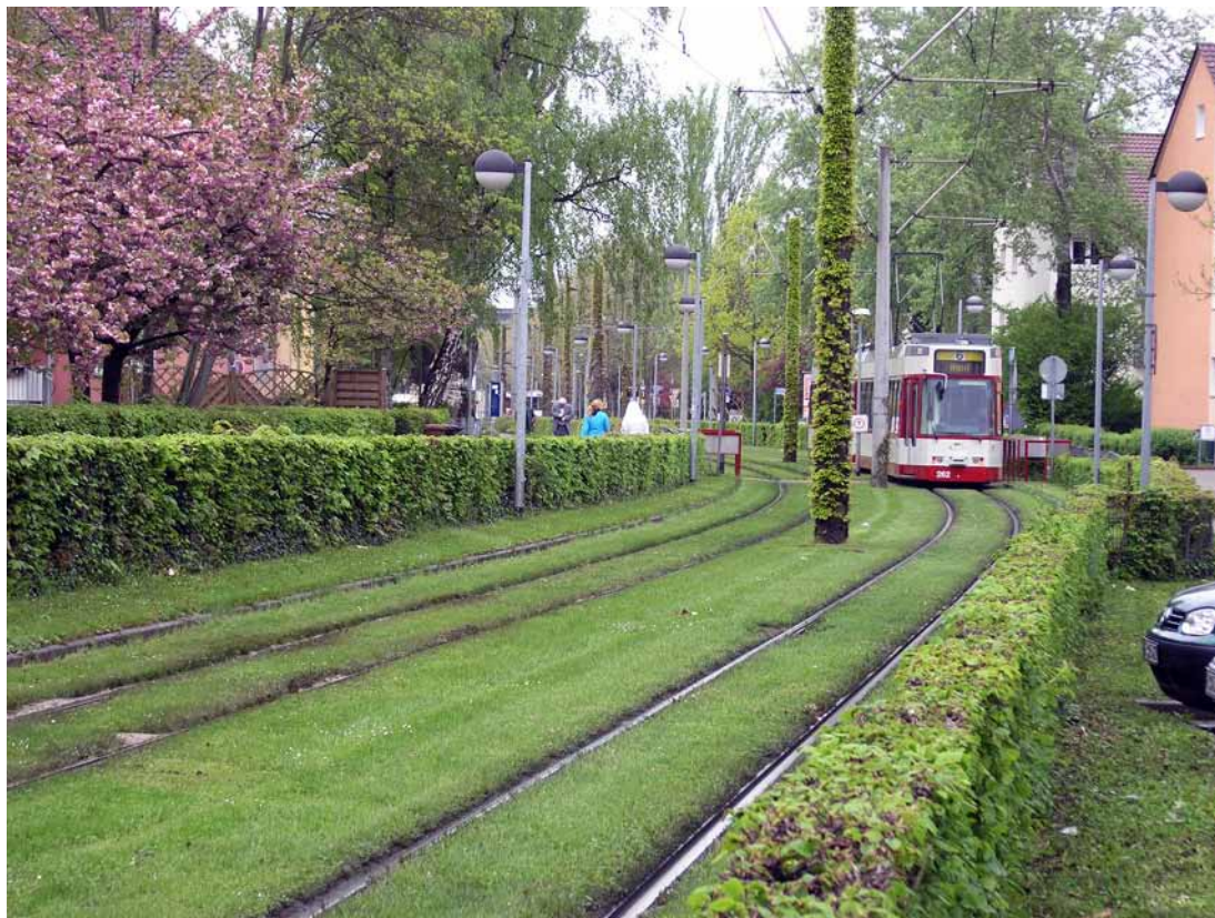
Kuva 17. Nurmetettu rata on kaupunkirakenteen viherelementti. Meluttomana ja hajuttomana nurmirata sopii asuinrakennusten yhteyteen ja puistoihin kävelyreittien rinnalle. Freiburg, Saksa 2005.
