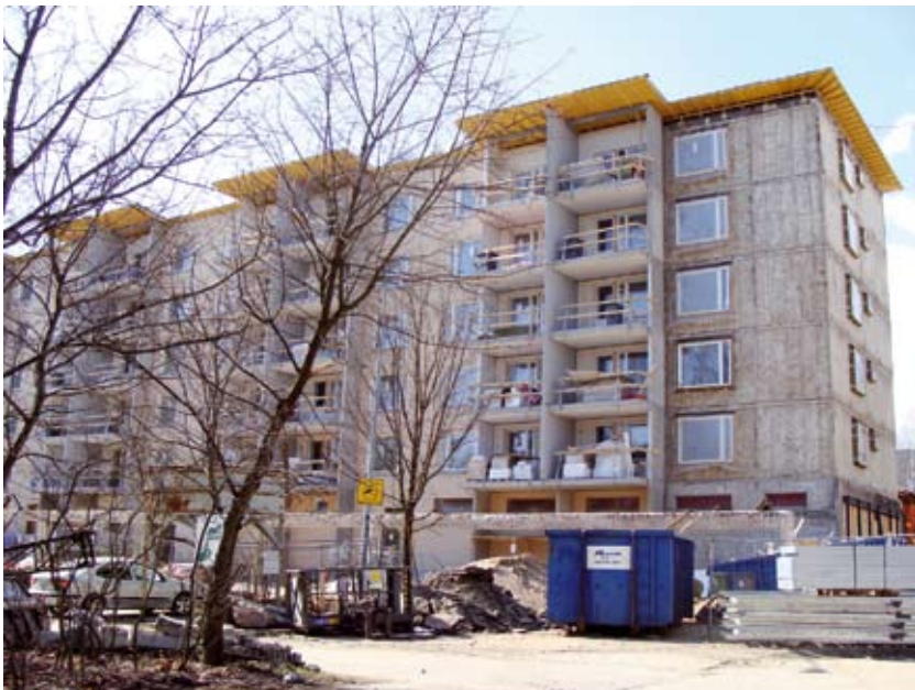
Kuva 2. Jakomäen vuokrataloja peruskorjattiin keväällä 2008.
