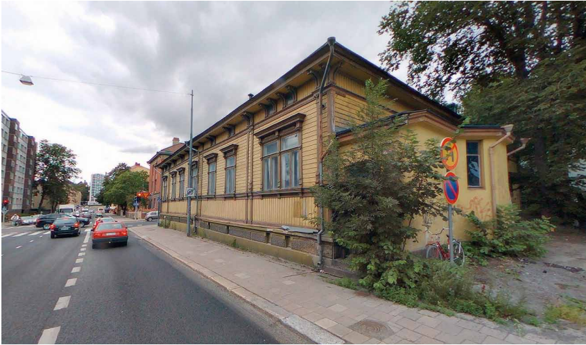
Kuva 4. Eerikinkadun puoleinen puutalo vuodelta 1853. (Kuva: Asemakaavatoimisto)
