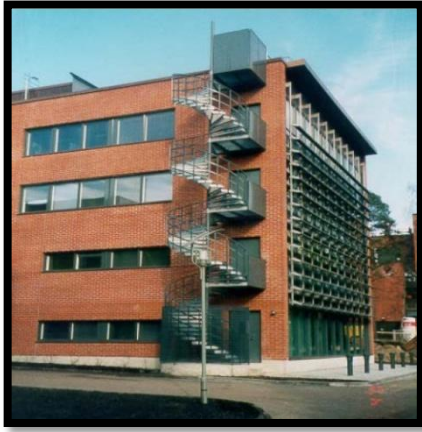
Kuva 20. Otaniemessä Teknillisen Korkeakoulun sähkötalon aurinkosähköjärjestelmä. [8]
