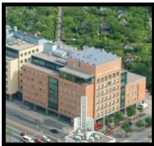
Kuva 24. NCC:n Helsingin pääkonttori. [20]
