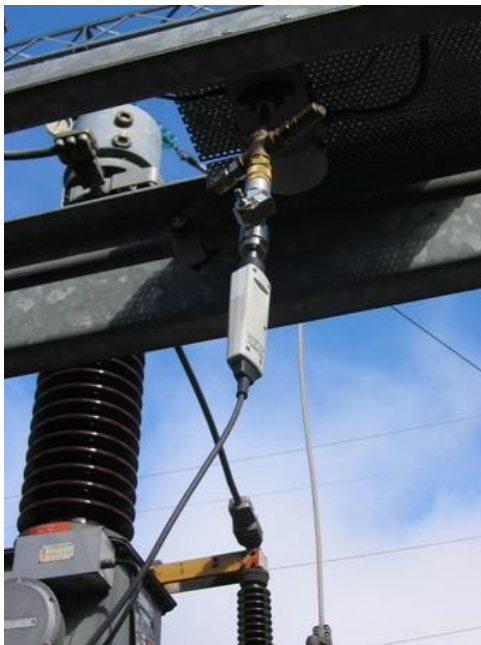
Kuva 4: Kastepisteen mittausta sähkölaitoksella DM70-käsimittarin avulla [3]
