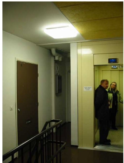
Kuvat 12 ja 13. Käytävän uusi valaistus. Valaisimina 2*24W pyöreitä muovikupuvalaisimia ja 2*36W neliö muovikupuvalaisin.
