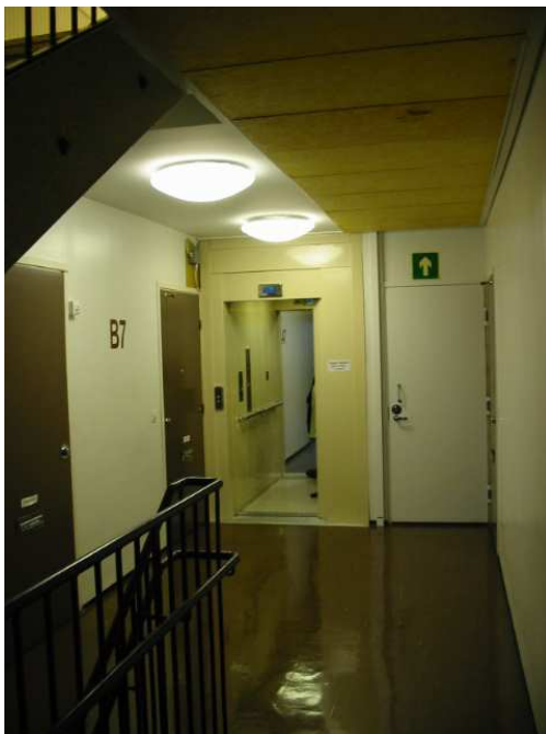
Kuvat 12 ja 13. Käytävän uusi valaistus. Valaisimina 2*24W pyöreitä muovikupuvalaisimia ja 2*36W neliö muovikupuvalaisin.
