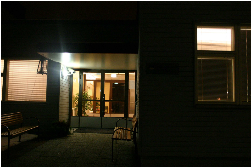
Kuva 3. Ulko-oven luona on riittävä valaistusvoimakkuus, mutta sisäänkäynti ei kuitenkaan erotu julkisivusta.
