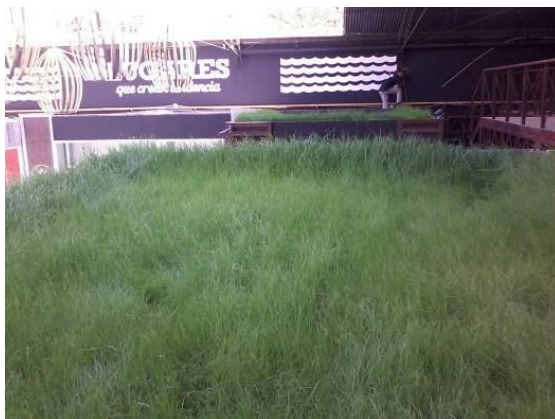
Figura 2. Vista superior de la cubierta verde-primavera
