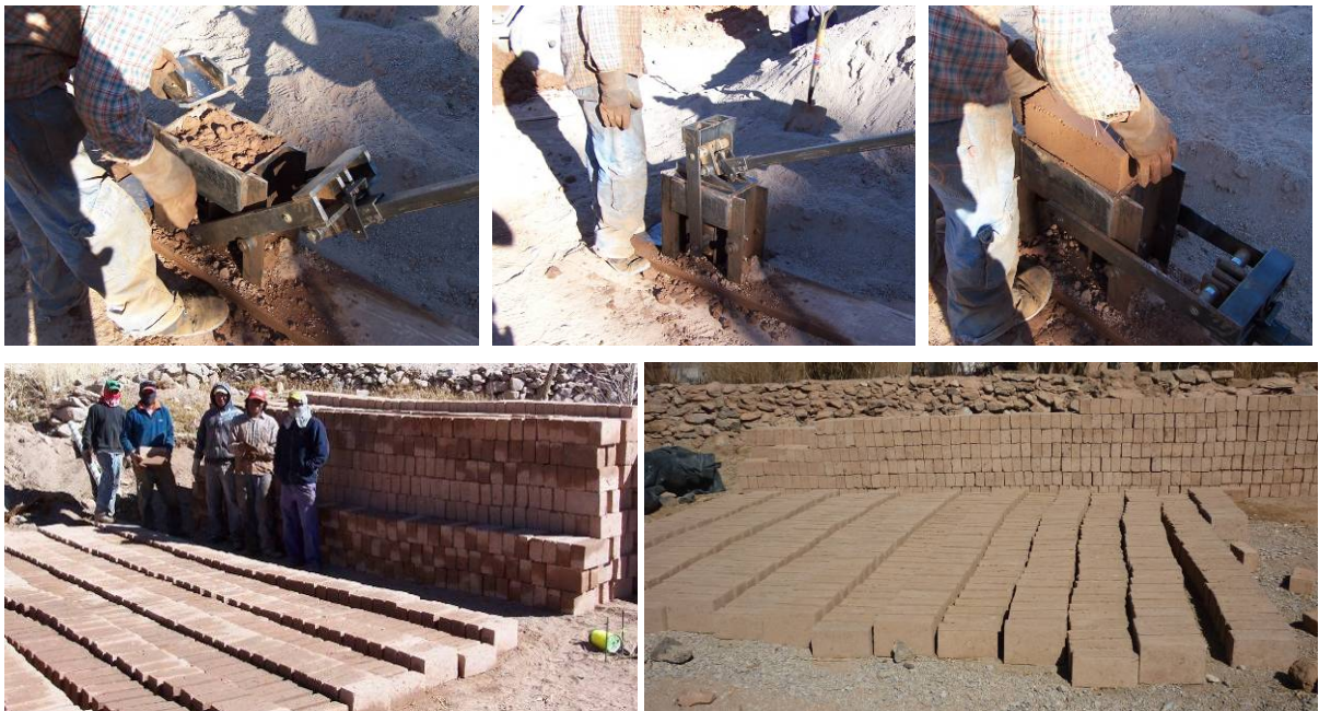
Figuras 3-4- 5- 6 y 7- Fotografías del proceso de construcción de los bloques con CINVA-RAM.
