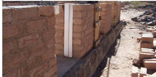
Figura 12 Fotografía mampostería doble c/aislación
