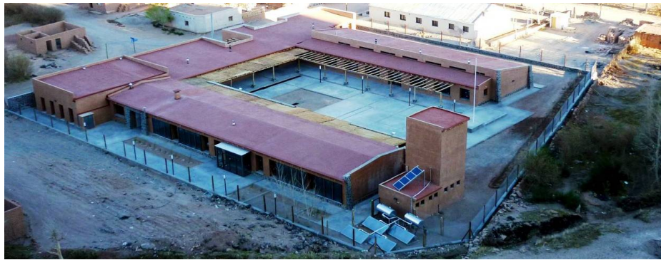
Figura 22 Fotografía de aérea de la escuela terminada
