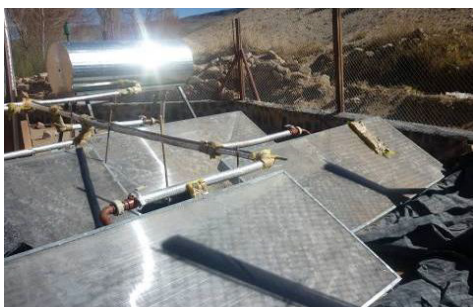
Figura 19 Colector solar plano y tanque
