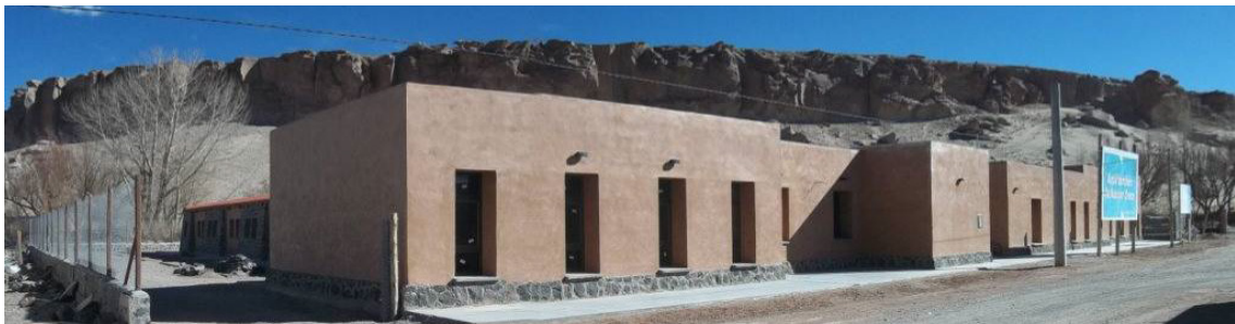
Figura 9 Fotografía fachada principal de la escuela terminada
