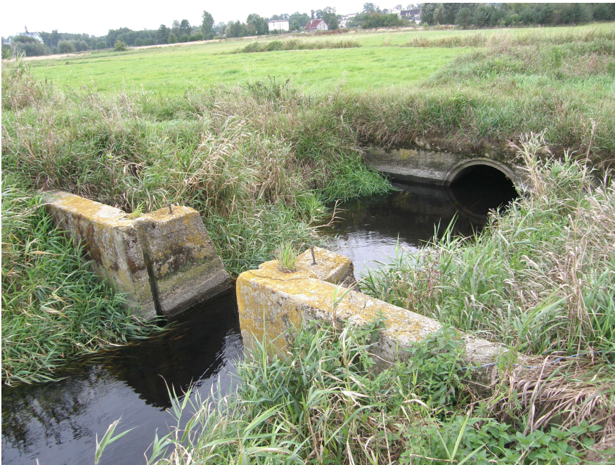
Fot. 3. Doprowadzalnik na lewym brzegu Neru przed jazem w Kazimierzu. W dalekim planie zarośnięty rów odwadniający (fot. K. Wroński).
