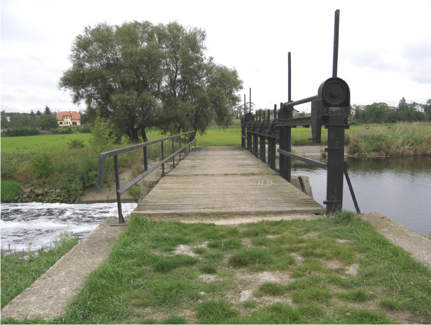
Fot. 4. Jaz w Kazimierzu podczas piętrzenia (fot. W.Tołoczko).
