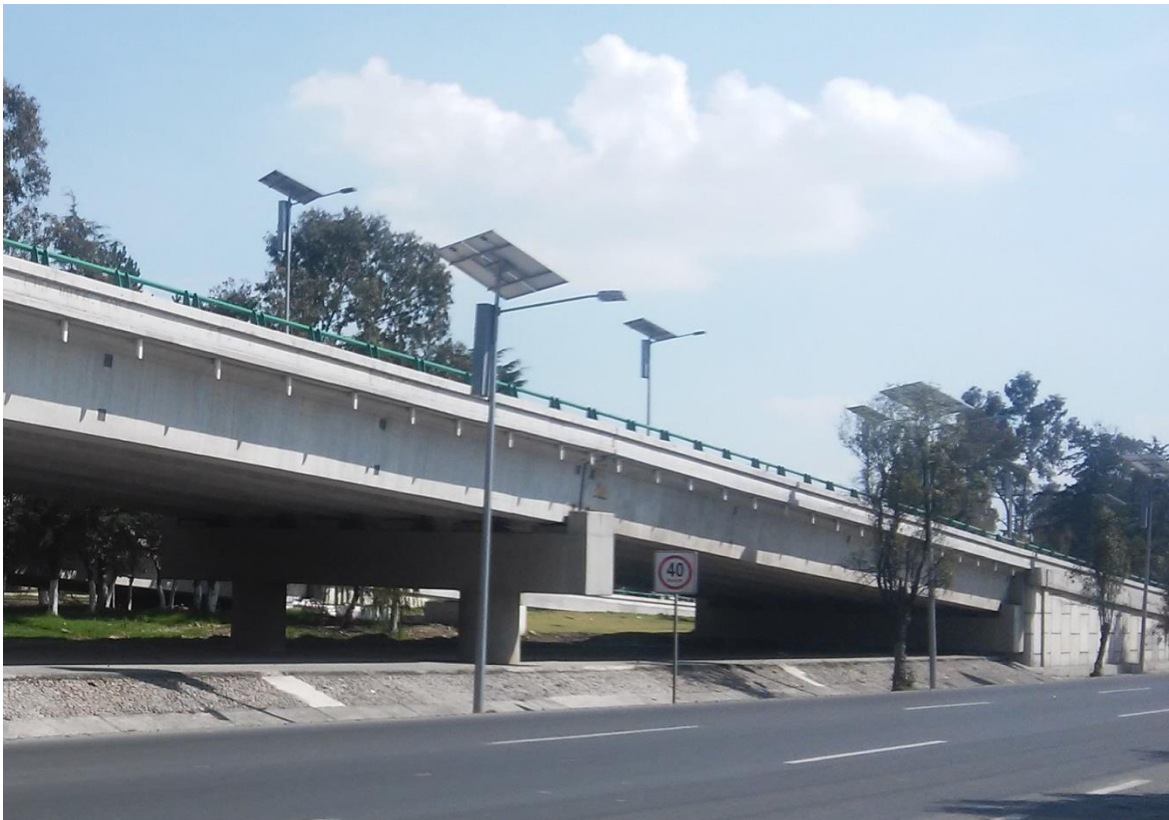
Figura 4.1.3.b Claro extremo del puente donde se llevaron a cabo las pruebas
