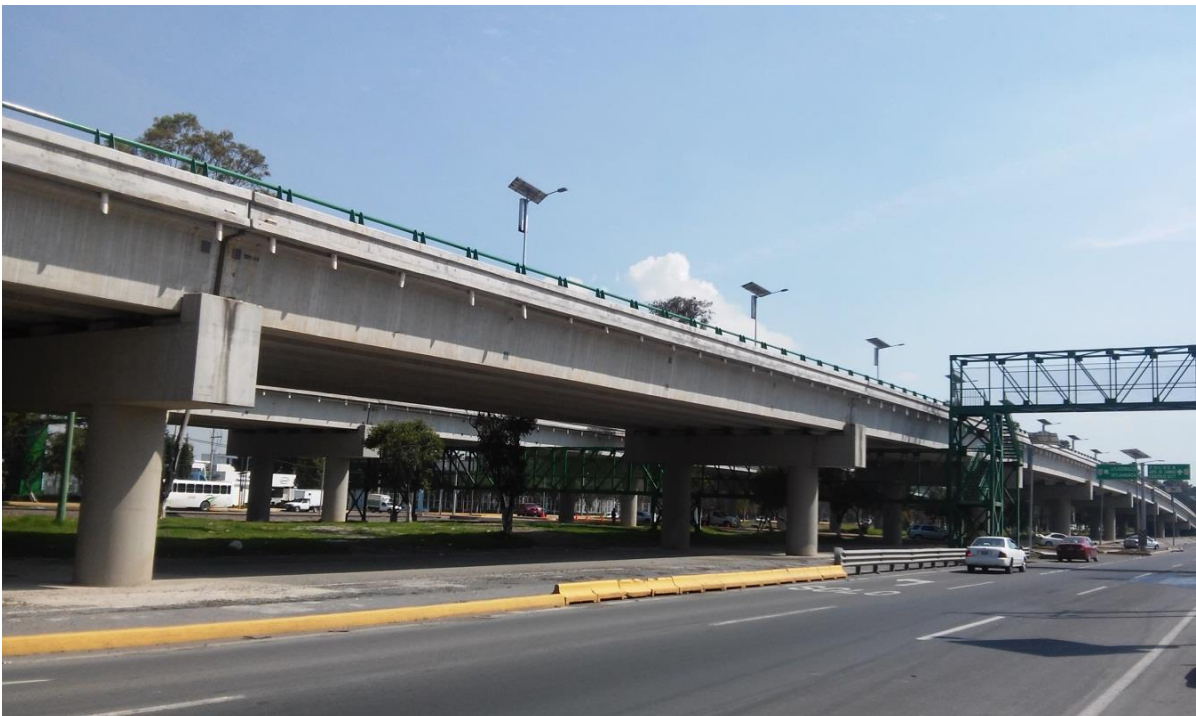
Figura 4.1.1 Puente vehicular en estudio
