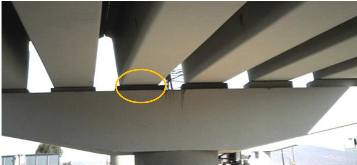
Figura 1.1.5 Ubicación de los apoyos convencionales elastoméricos
