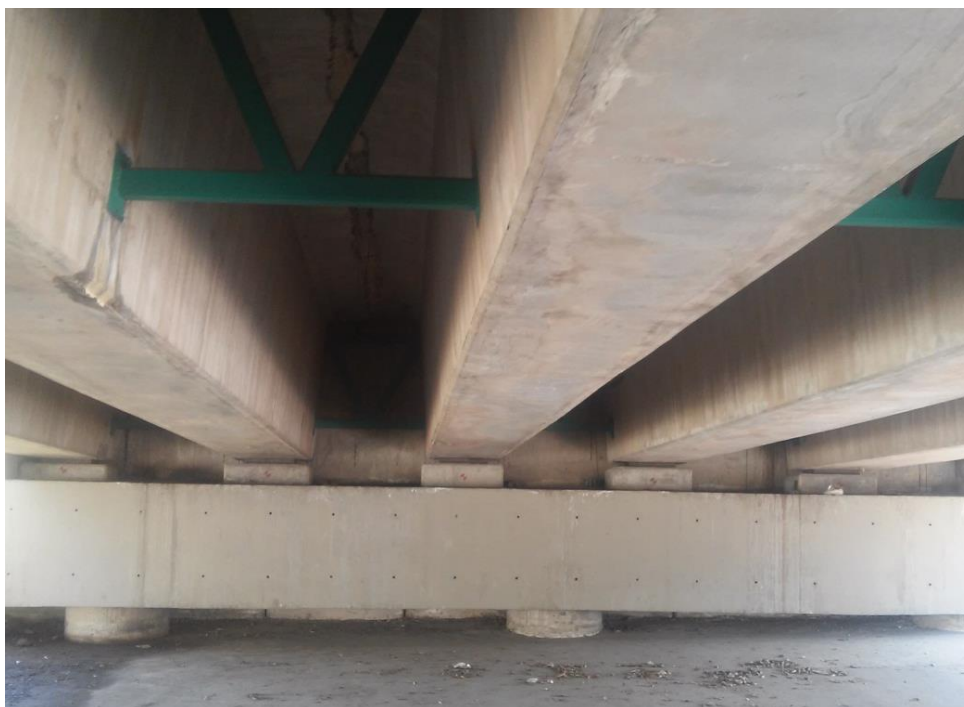
Figura 1.2.1 Apoyos de neopreno del puente en estudio
