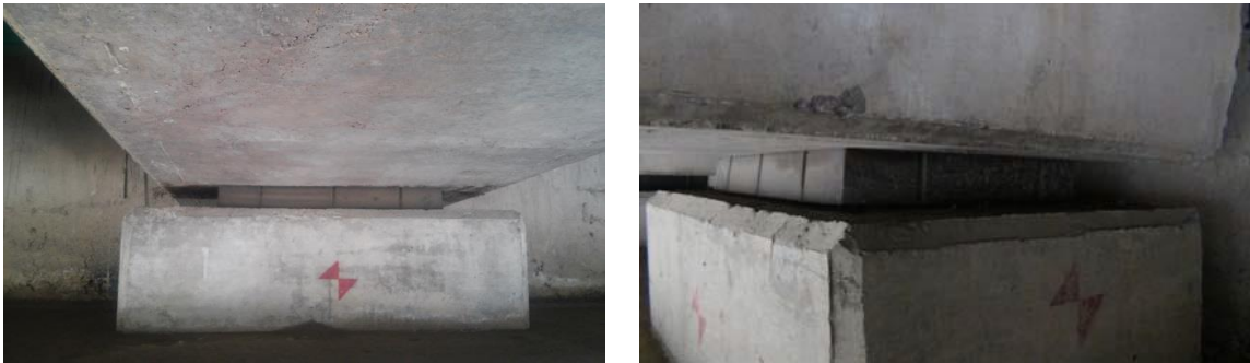
Figura 4.1.8 Apoyos de neopreno del puente vehicular que se estudia
