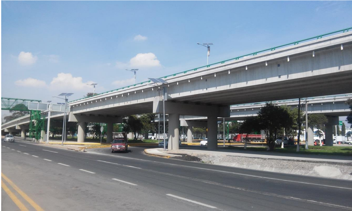
Figura 1.1.7 Puente Toluca – Palmillas, municipio de Toluca, Estado de México
