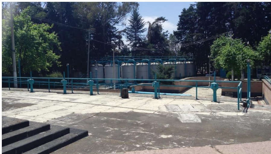
Foto 2. Instalaciones del sistema Lerma, Almoloya del Río
