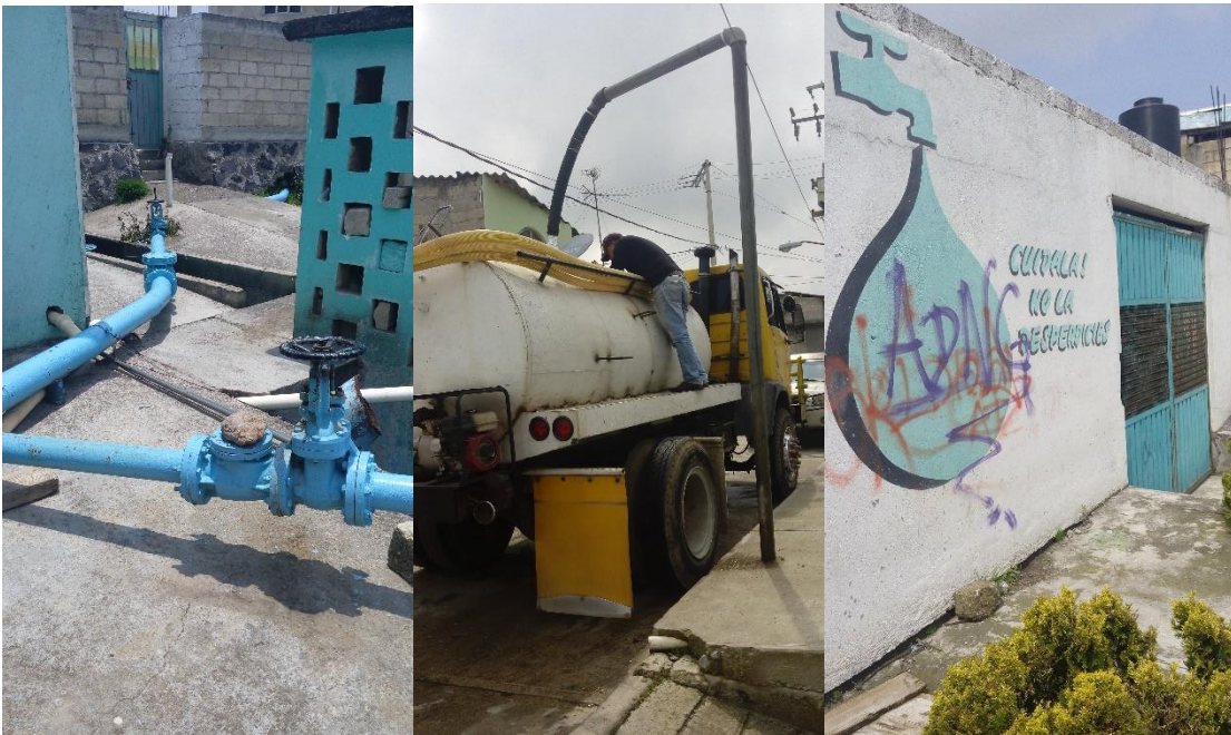
Foto 4. Instalaciones de las oficinas del Comité del Sistema Cuauhtémoc
