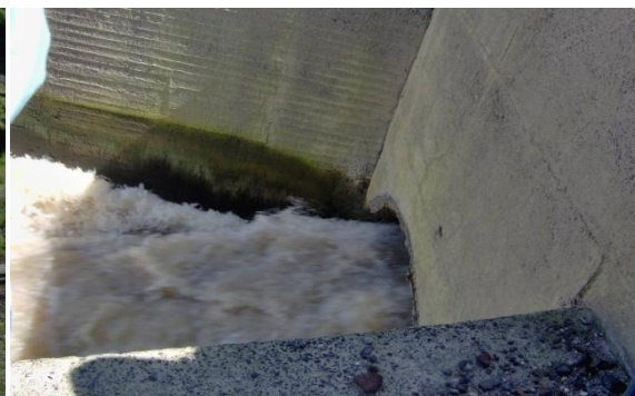
(b) Obra de toma aguas abajo
