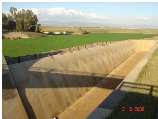
(b) Obra de Excedencias
