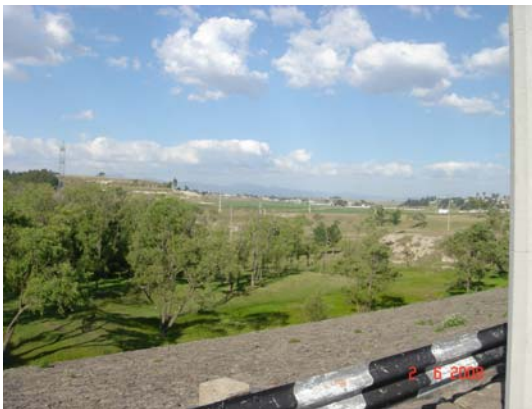
(a) Vista aguas abajo de la cortina
