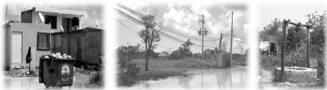
Figura 2. Condiciones en las que se encuentran las viviendas, los caminos e infraestructura urbana en el km. 55 de Mahahual, Quintana Roo
