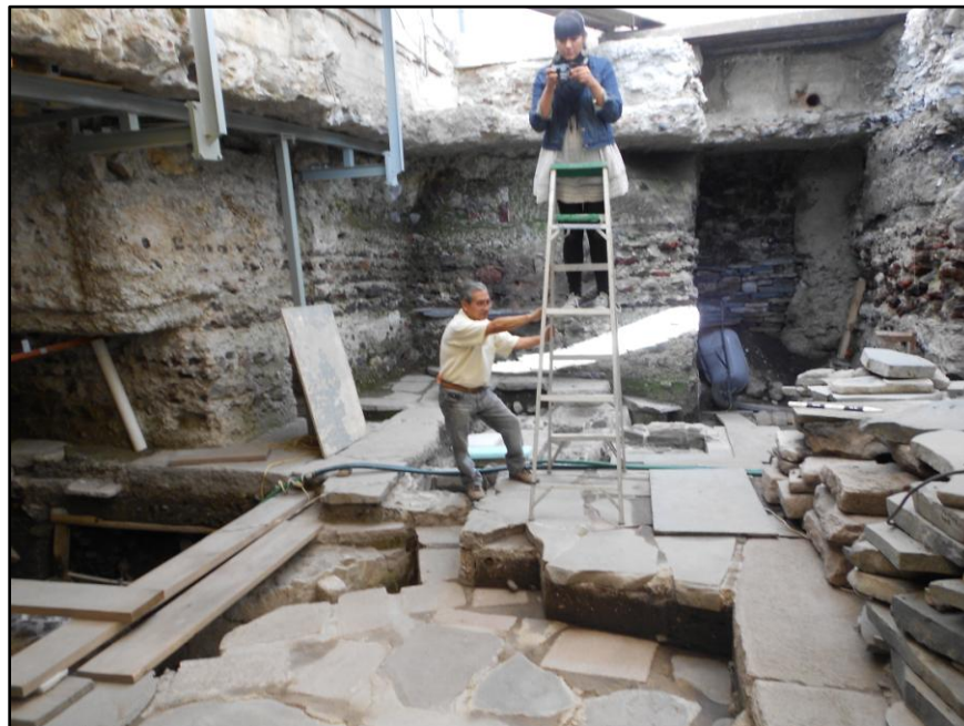
Imagen 49. Piso 2 Etapa VI, Registro topográfico. Foto: Carmen Janeth Flores Islas
