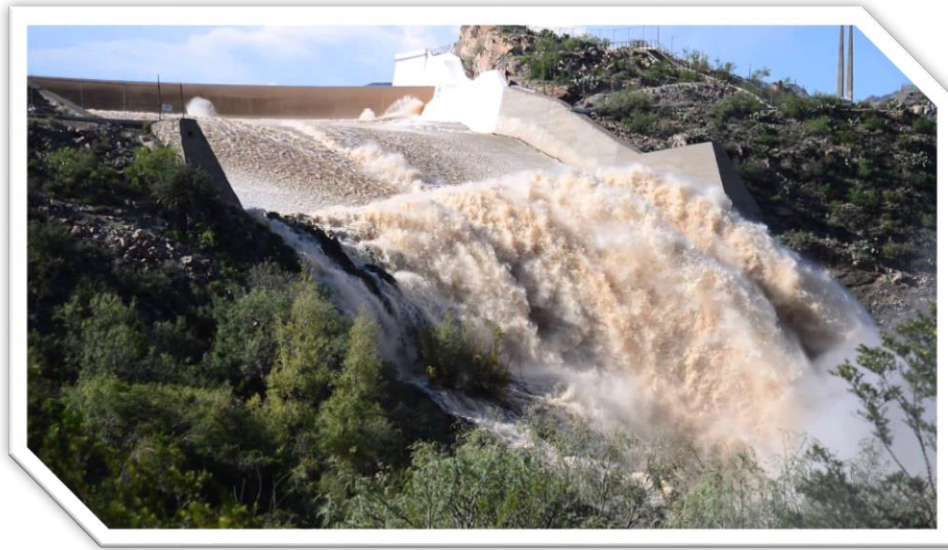
Figura. 7 Rompimiento de una presa por mala Operación Fuente: Tomado de https://www.youtube.com/watch?v=3HMxiB1cnug ).
