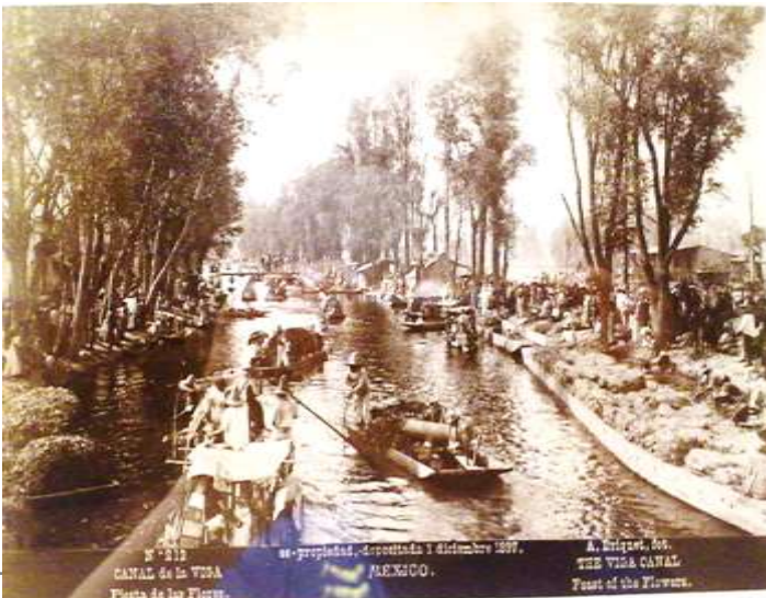
Fotografía 1: “Canal de la Viga”
