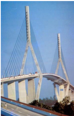
Figura I.2. Arreglo de tirantes en el Puente Tampico.
