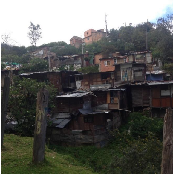
Figura 3. Asentamiento sobre la quebrada San Bruno. Fuente: Elaboración propia (2016). CC BY
