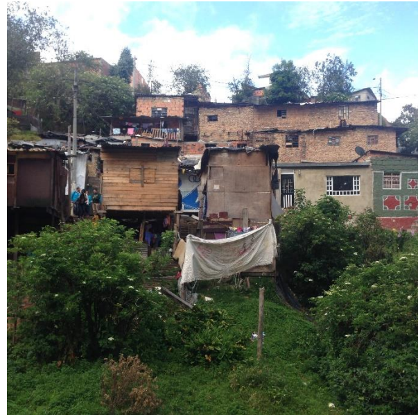
Figura 4. Asentamiento sobre quebrada San Bruno. Fuente: Elaboración propia (2016) CC BY
